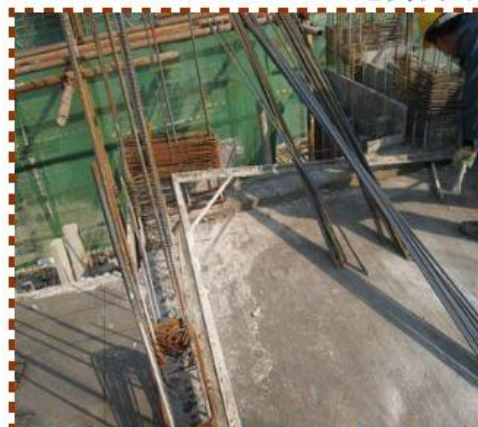
【剪力墙截面控制撑块】
