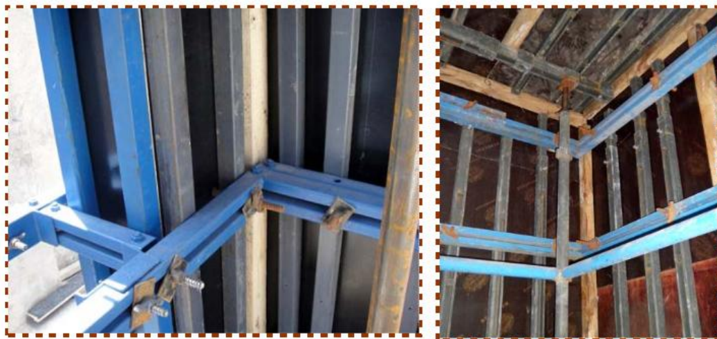
【定型方钢剪力墙模板阴角加固】
