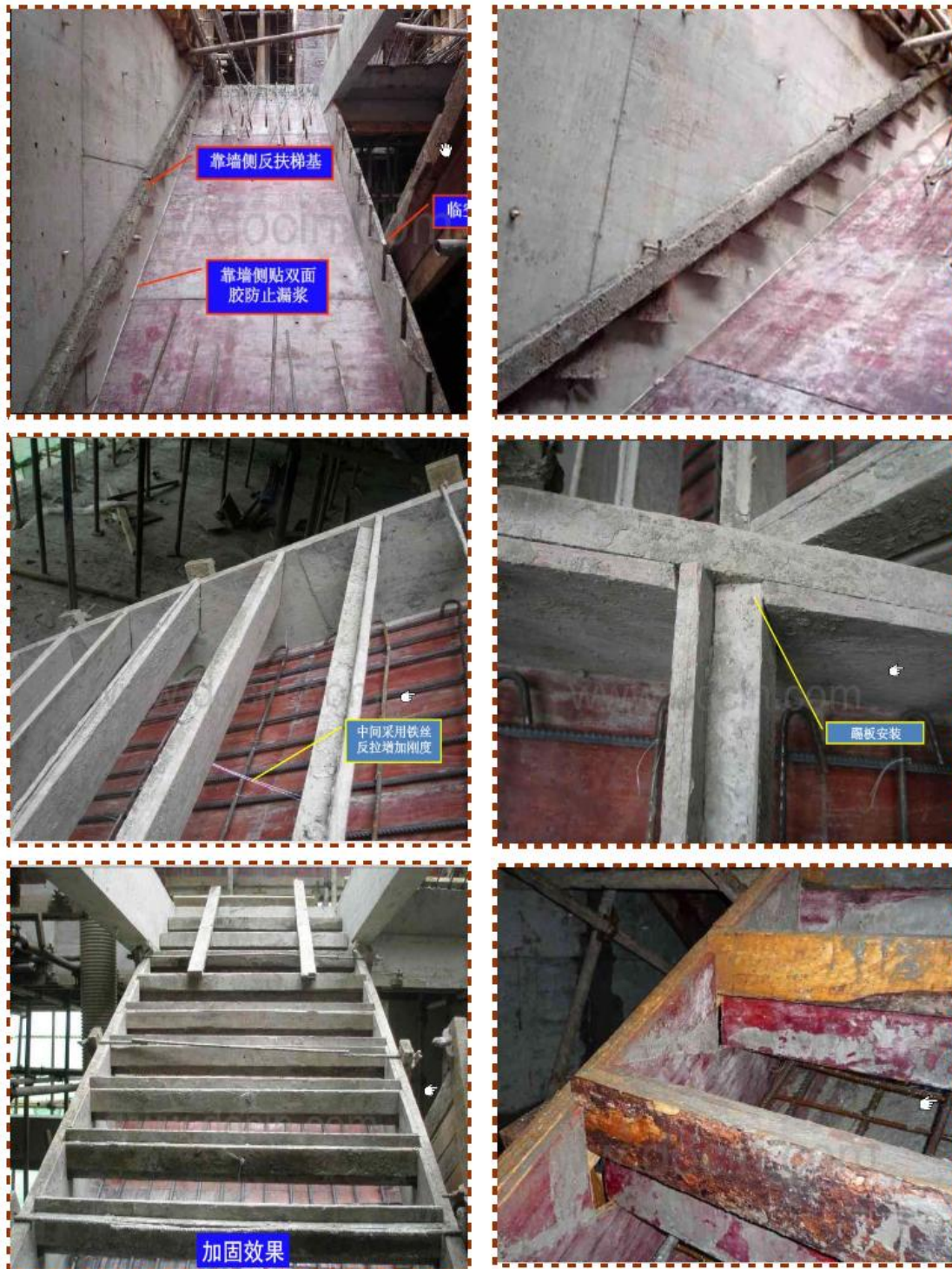
【楼梯模板模板支设】
