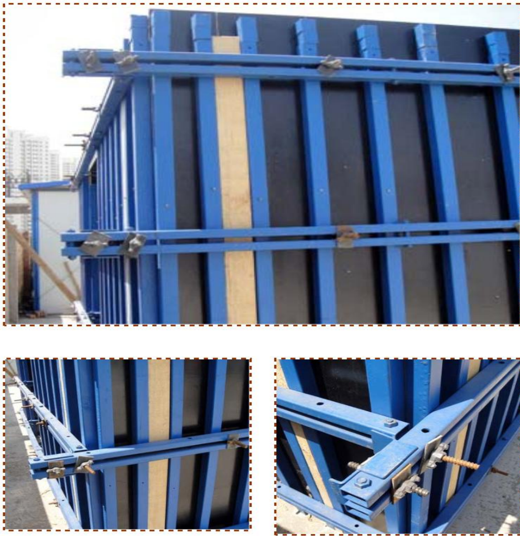
【定型方钢剪力墙模板阳角加固】
