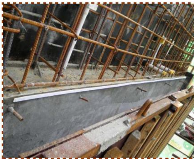
【剪力墙外墙根部处理】
