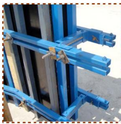
【定型方钢剪力墙模板洞口封头加固】
