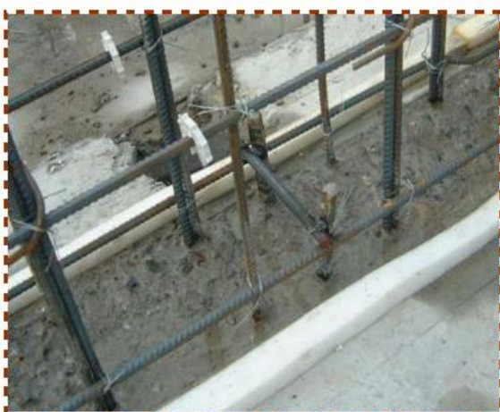
【剪力墙根部沿墙边线通长贴 10 厚海绵条，调节楼板标高，防止漏浆】
