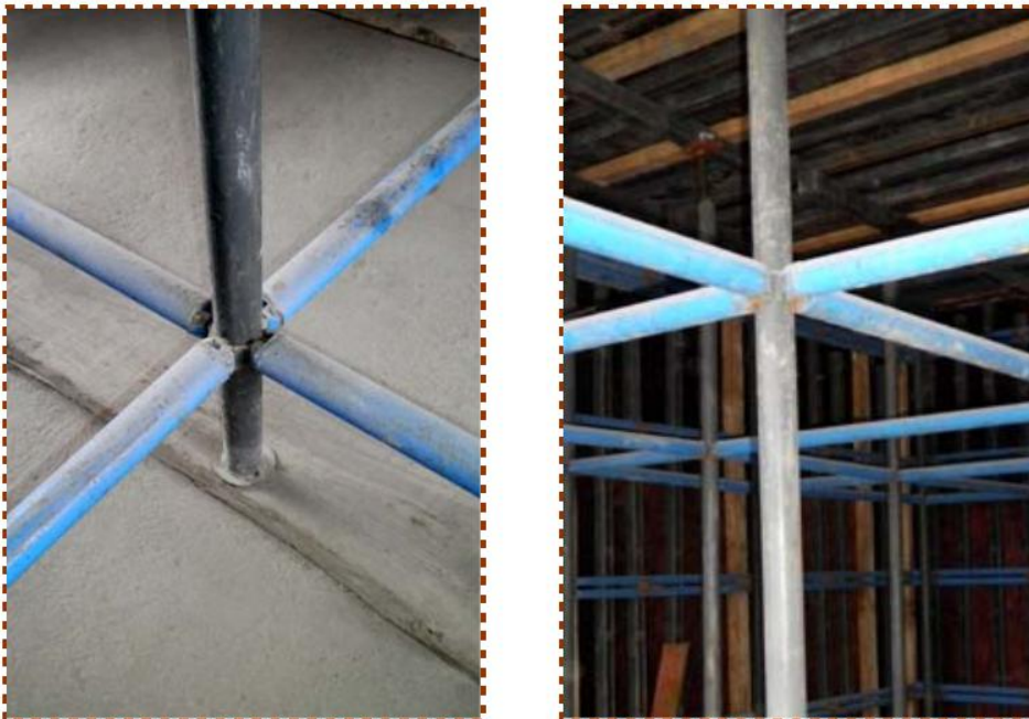
【插销式排架体系连接节点】
