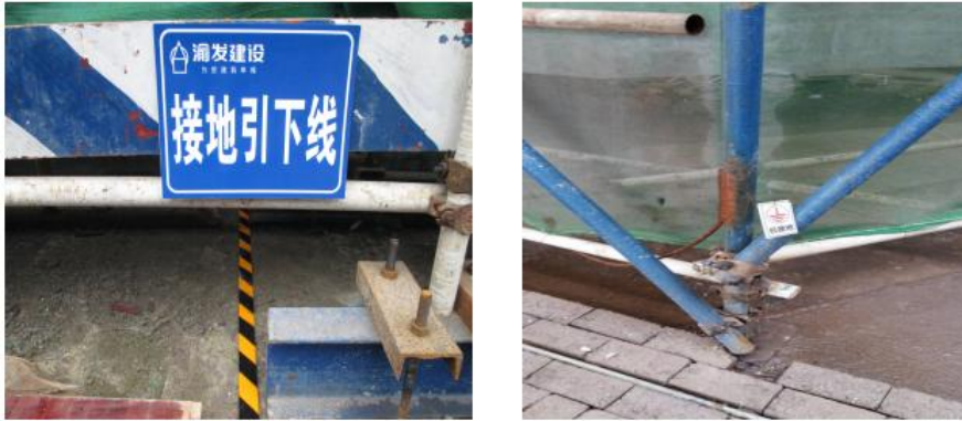
外架、小型机具接地设施
