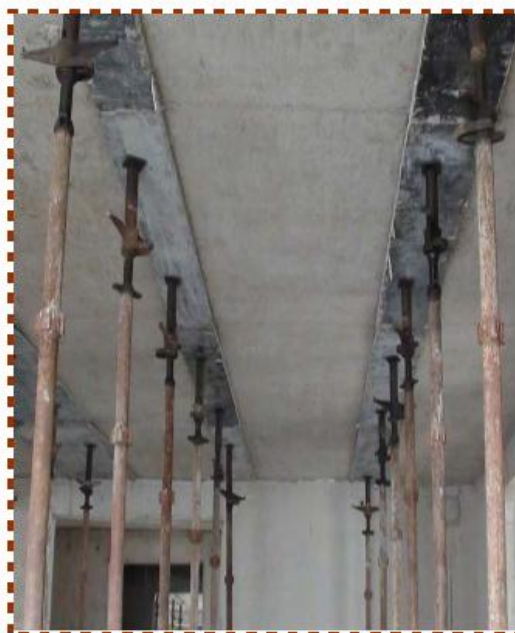
【顶板后浇带早拆模体系】
