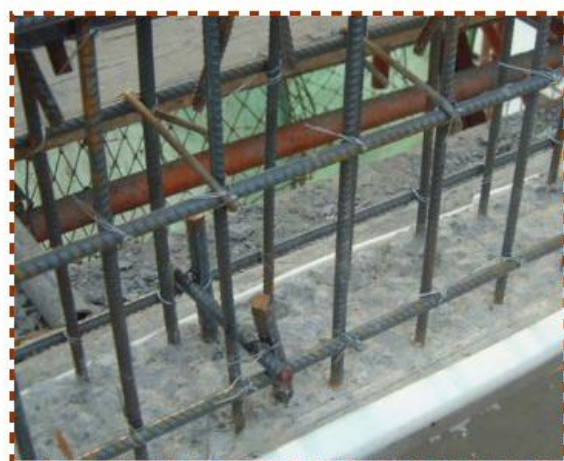
【剪力墙根部沿墙边线通长贴 10 厚海绵条，调节楼板标高，防止漏浆】
