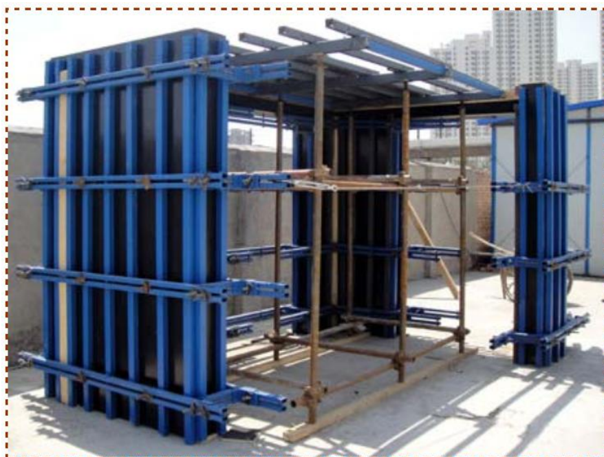
【定型方钢剪力墙模板体系实物样板】
