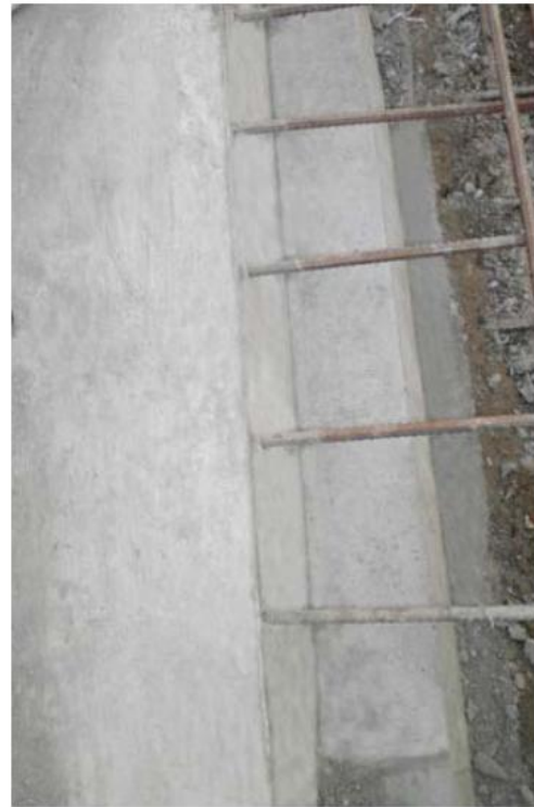
【基础后浇带处理】
