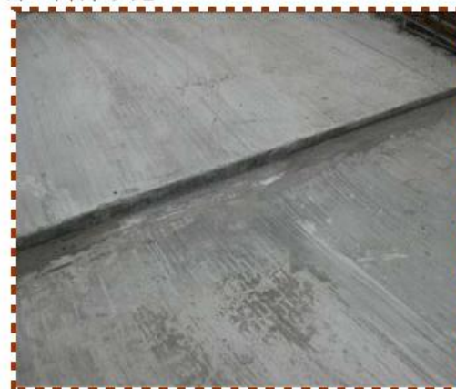
【楼板沉板处理】
