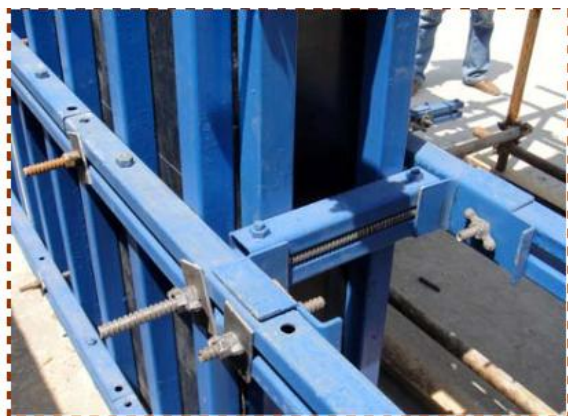
【定型方钢剪力墙模板洞口封头加固】
