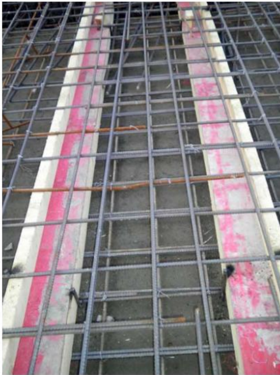
【基础后浇带处理】
