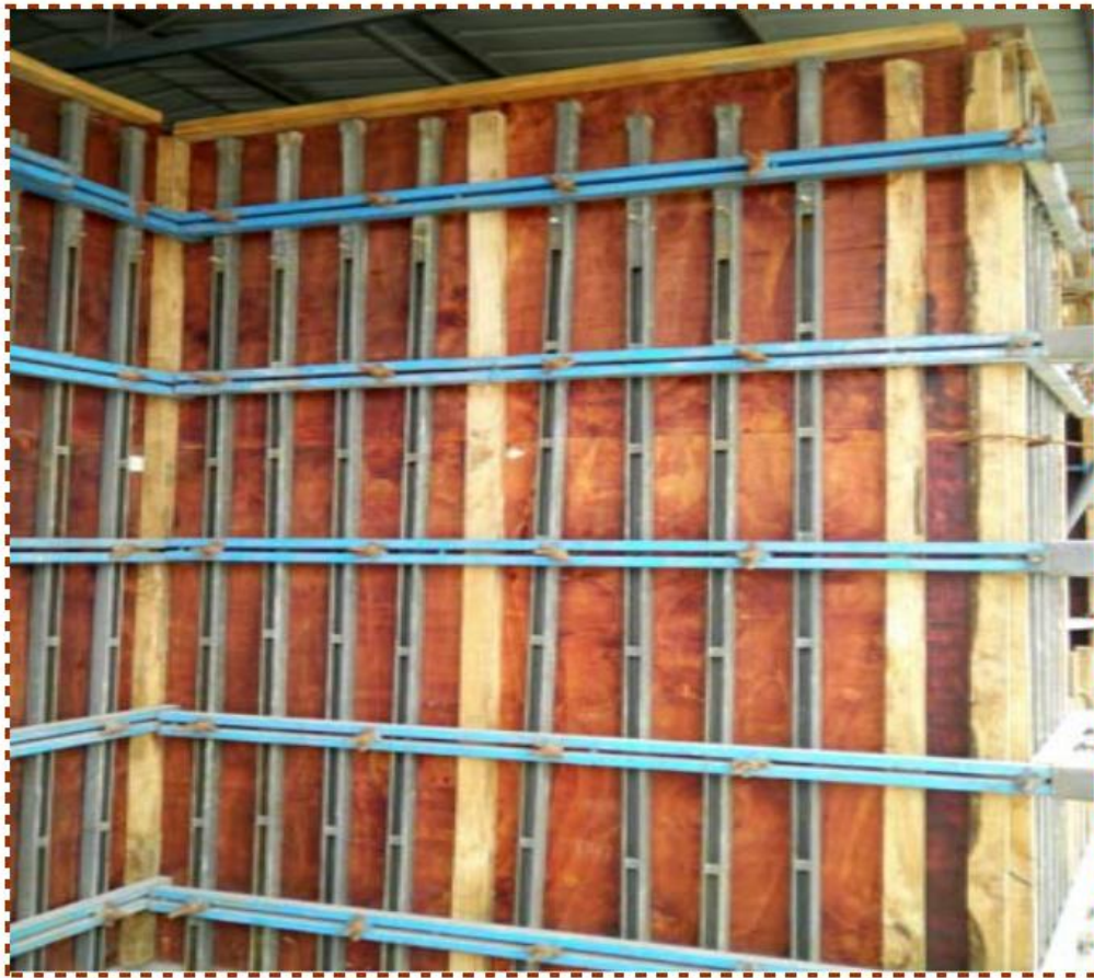
【定型方钢剪力墙模板配模】
