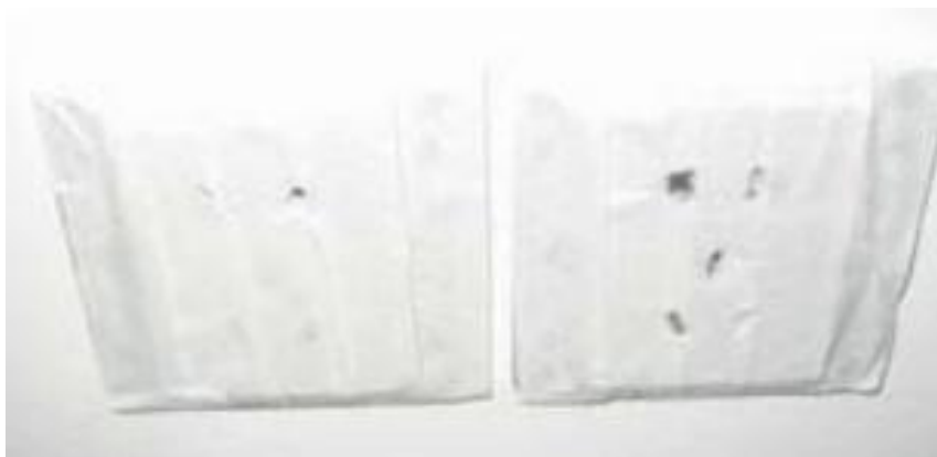
图 4.5-21 开关插座成品保护
