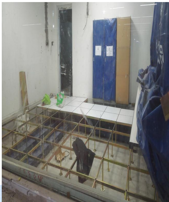
防静电地板安装
