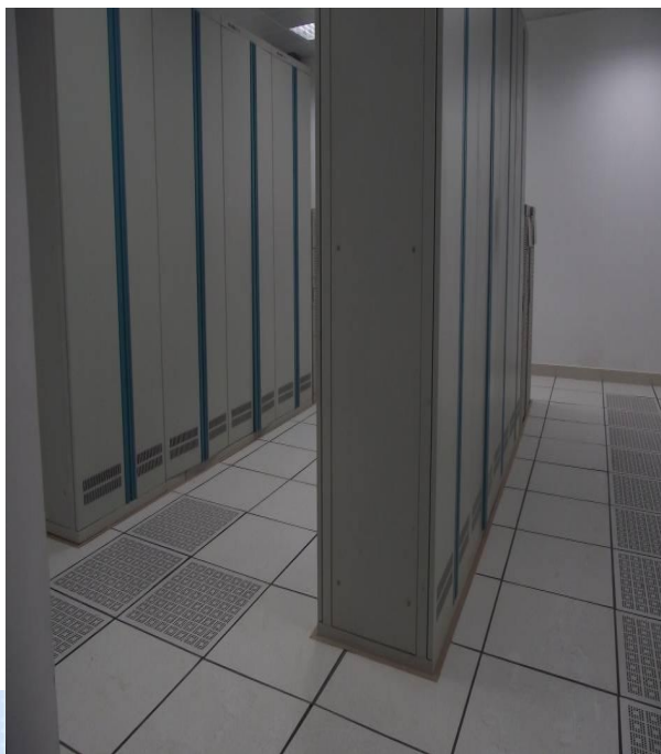
防静电地板安装完成
