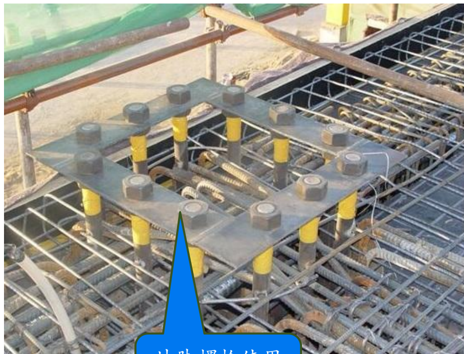
地脚螺栓使用 钢套板定位
