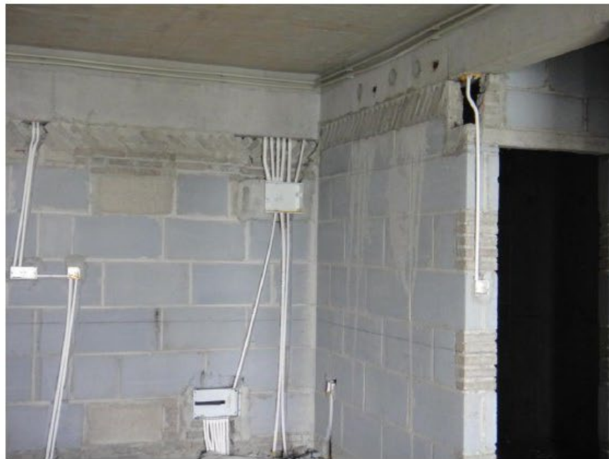
2、线槽等也使用石膏抹灰材料封堵
