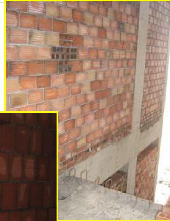
●砌体安装留洞宽度超过300mm以上时，洞口上部应设置过梁。消防箱、卫生间墙体洞口宽度小于600mm应设置的钢筋砖带过梁，否则应采用预制过梁或现浇过梁。
