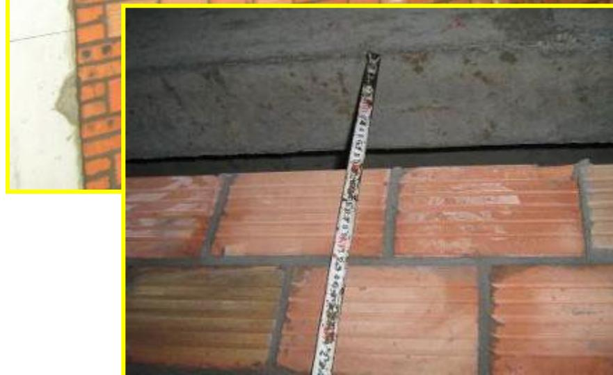
●后塞口斜砖逐块敲紧挤实，斜砌角度控制在 $60^\circ \pm 10^\circ$
