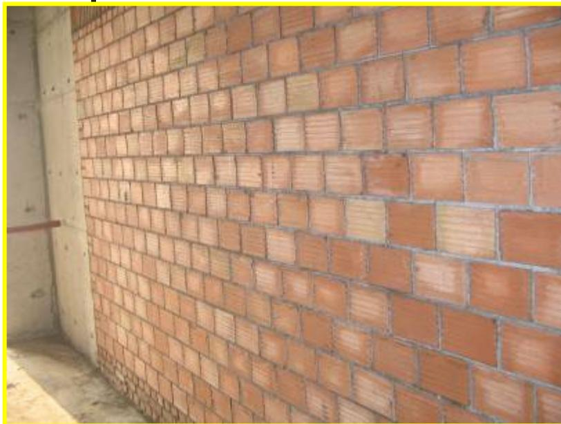
●砌筑灰缝应横平竖直，砂浆饱满不低于90%，竖缝不得出现挤接密缝。
