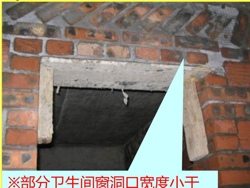
※部分卫生间窗洞口宽度小于600 mm设置钢筋砖带过梁
