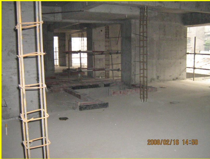
●构造柱纵向钢筋搭接长度要满足设计要求，搭接区域箍筋要进行加密。
