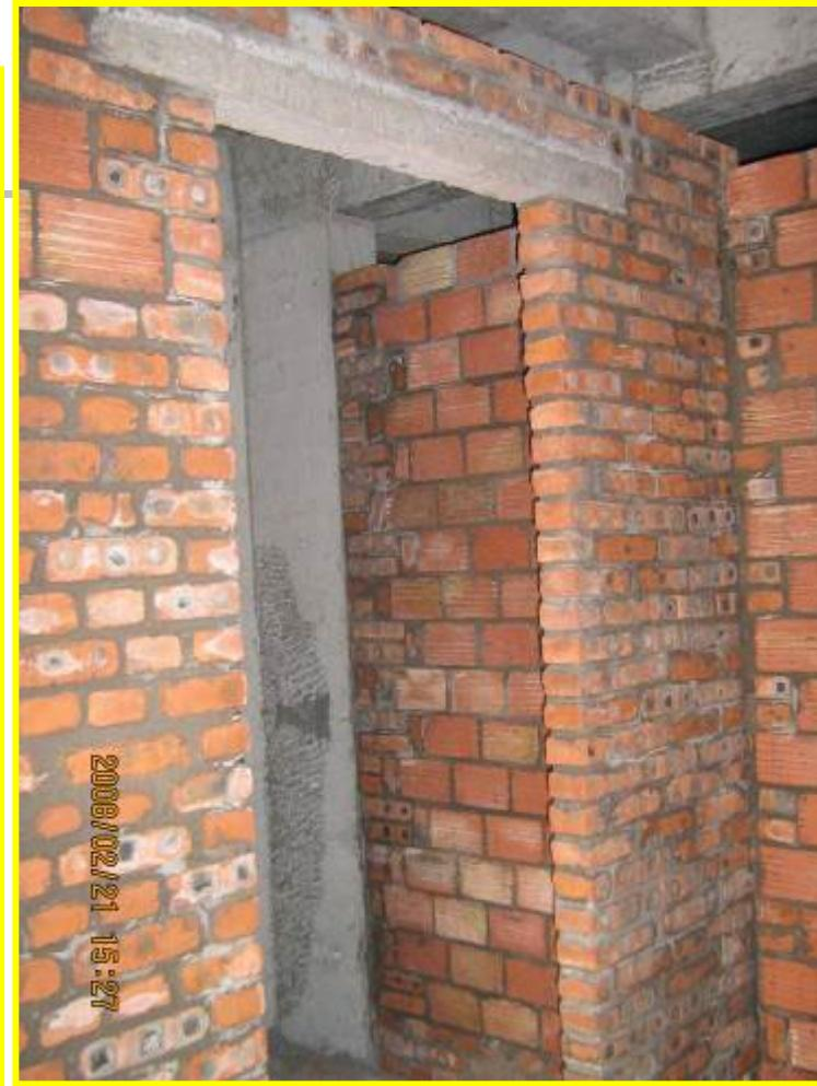
●改进措施：根据标高控制线，确定门窗砌筑高度及过梁安装标高。
