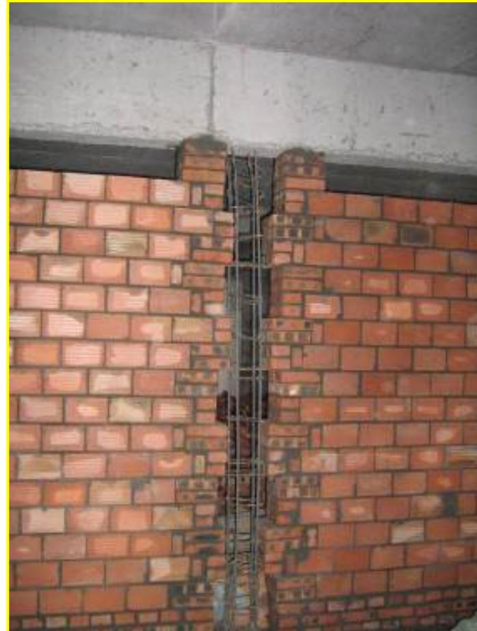
●砌体构造柱模板安装前，须清理干净底脚砂灰，并按要求贴双面胶堵缝，双面胶须弹线粘贴，保证顺直、界面清晰，完成后报监理检查。（所有二次构件钢筋、模板报验作为质量停止点检查之一）
