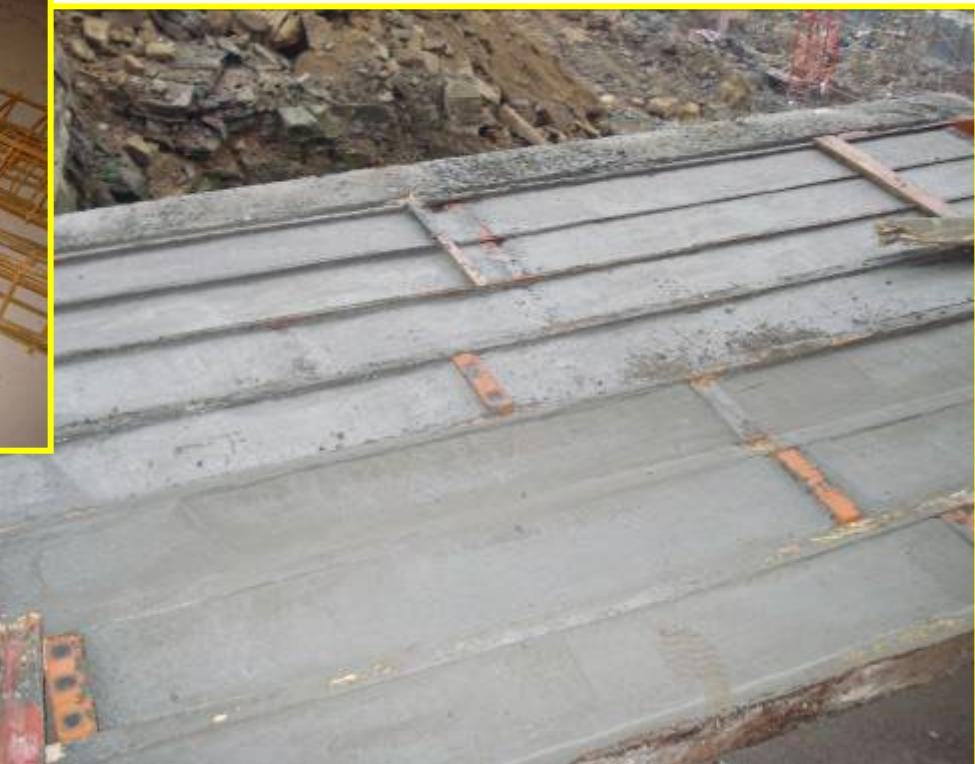
●过梁要求提前制作，安装时必须确保强度达到设计要求。（钢筋及砼材料须报验，强调做好砼试件取样、强度评定工作）
