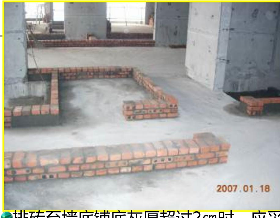
●排砖至墙底铺底灰厚超过2cm时，应采取细石砼进行铺底砌筑；门洞控制尺寸严格按图纸要求留设。
