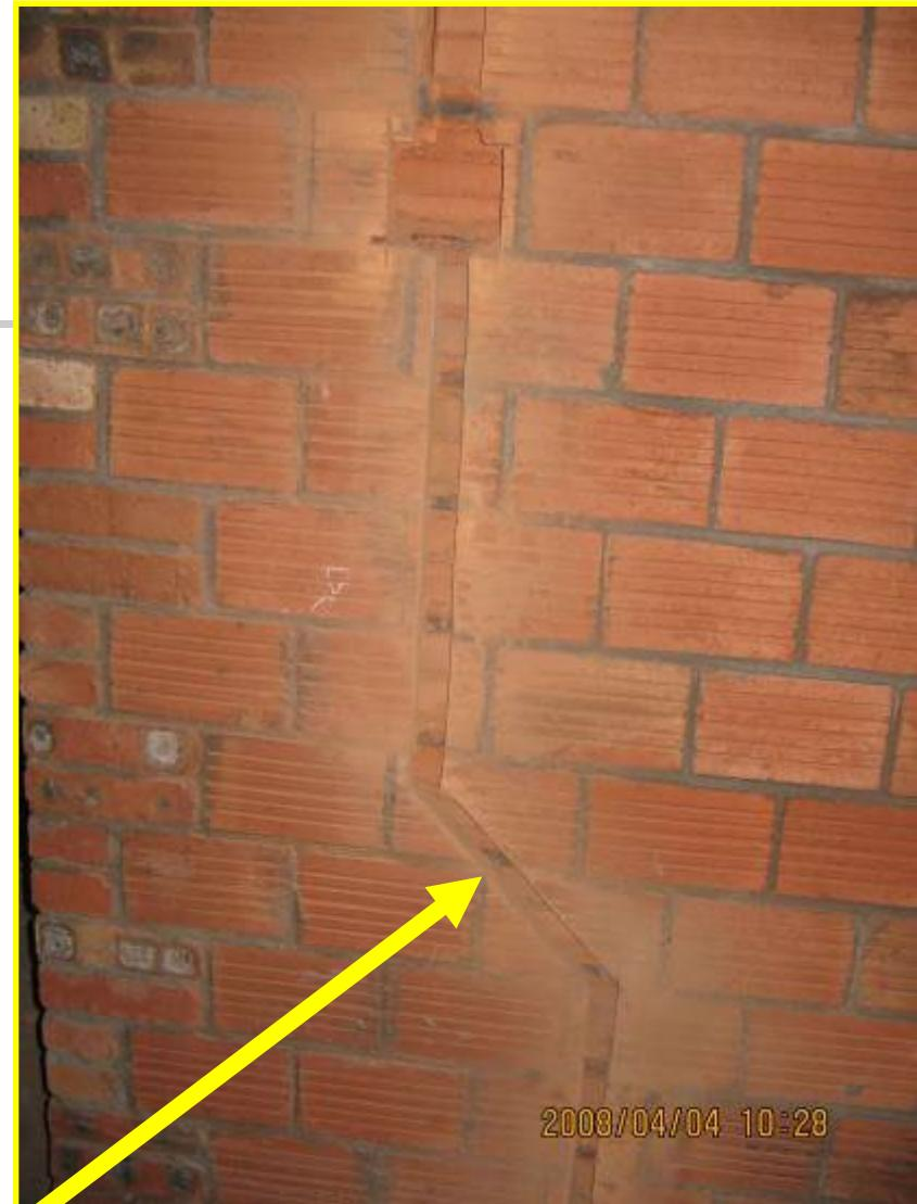
在砌体上严禁开水平槽，应采用45度斜槽。
