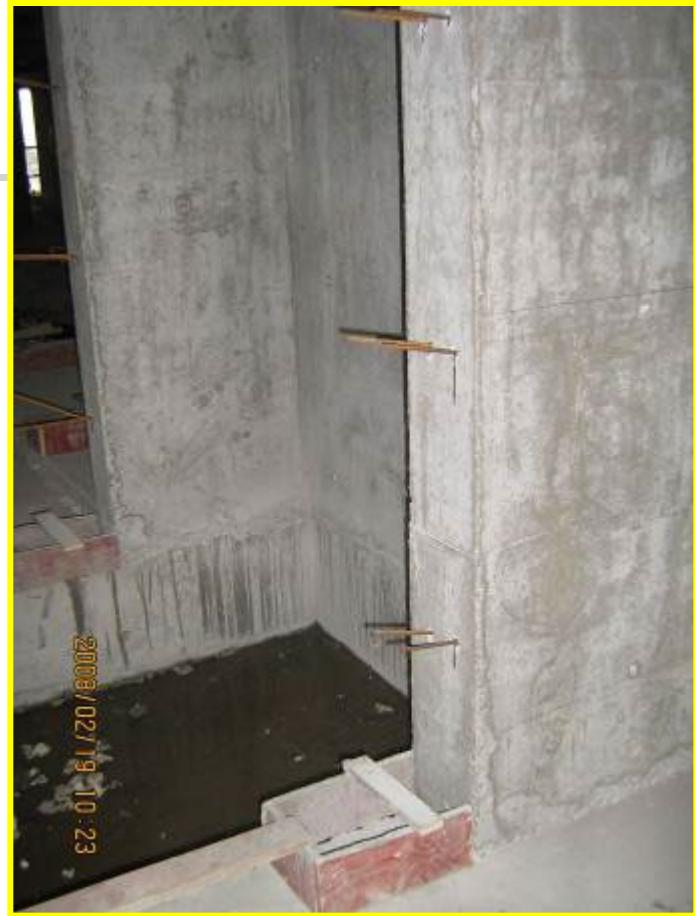
●改进措施：1、统一钢筋种类；2、根据门垛尺寸确定钢筋植筋位置。
