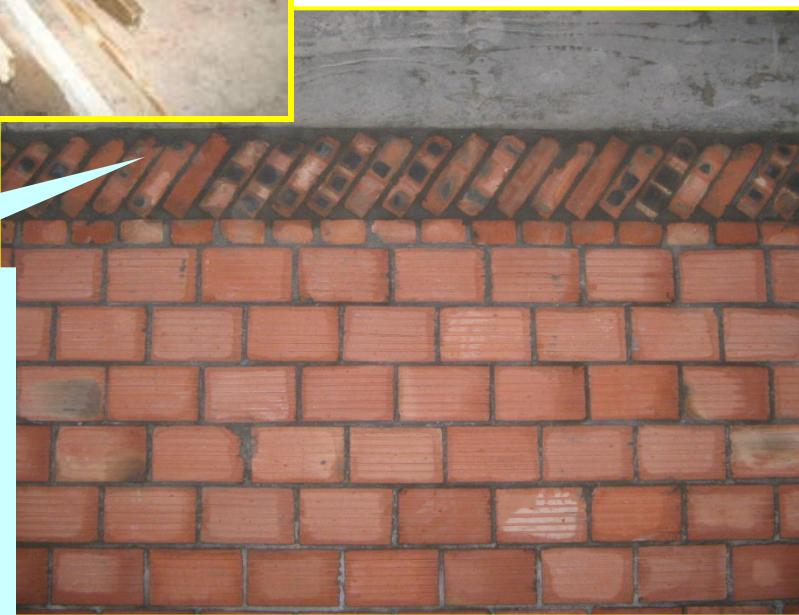
※重点注意砌体砂浆饱满度，特别是外墙后塞口砂浆饱满度的控制，以防止外墙渗漏。
