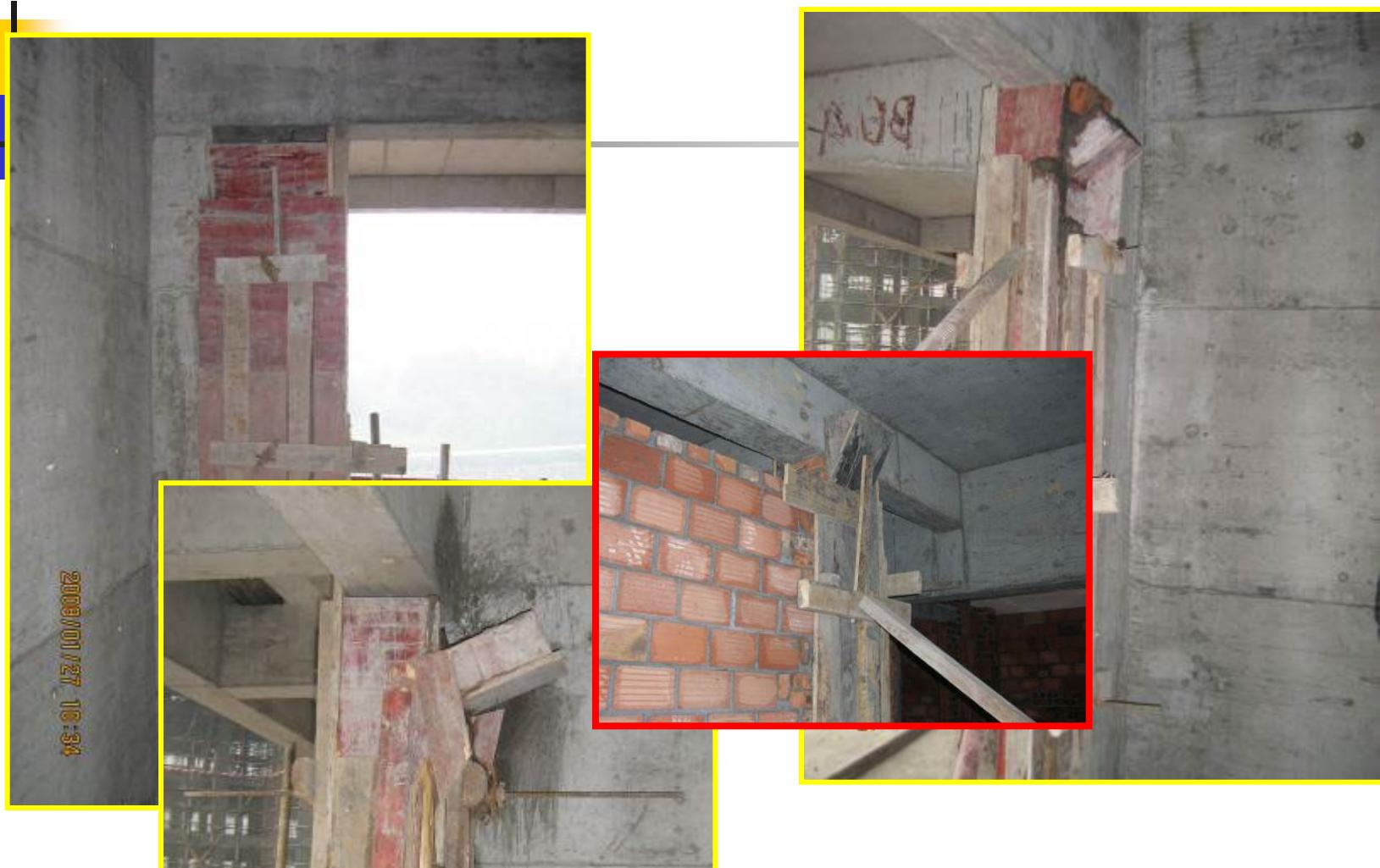
●改进措施：按推荐支模方式进行构造柱喇叭口的制作。
