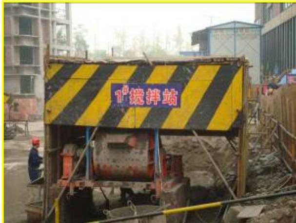
※建筑砂浆搅拌现场必须悬挂配合比报告，并配置磅秤，工人在操作过程中严格按照配合比进行搅拌，水泥砂浆必须在3H (2H) 内用完，严禁使用隔夜砂浆进行砌筑。监理在巡查过程中发现违规现象将严格进行处罚。
