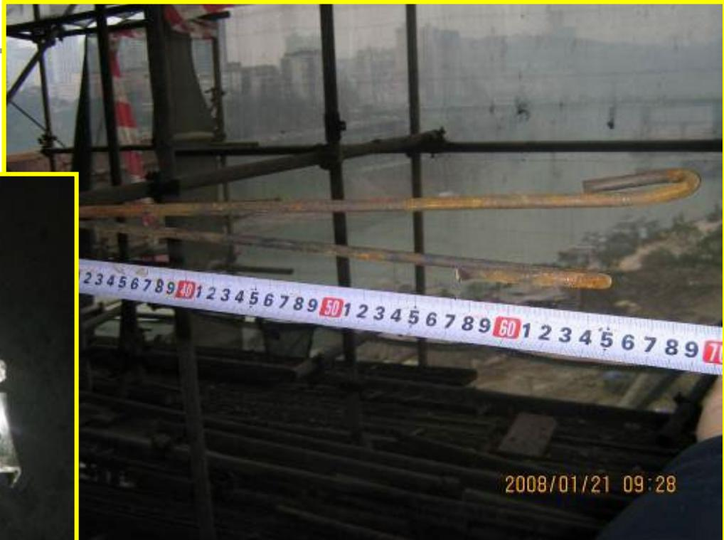
●改进措施：1、根据墙体长度确定不同墙肢的拉接筋种类；
