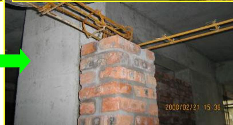
●墙顶后塞口斜砌须等墙体砌筑完成7天后再进行，后塞口采用多孔配砖砌筑，斜砌角度应控制在60度，两端可采用预制三角砼块或切割实心砖进行砌筑，斜砌灰缝厚度应宽窄一致，与墙体平砌要求相同
