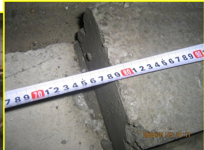
●改进措施：门窗洞口尺寸按砌体固化图留设准确并加强检查。
