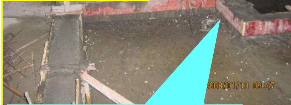
※砼浇筑前，必须进行凿毛，并用水冲洗湿润，浇筑时必须确保密实
