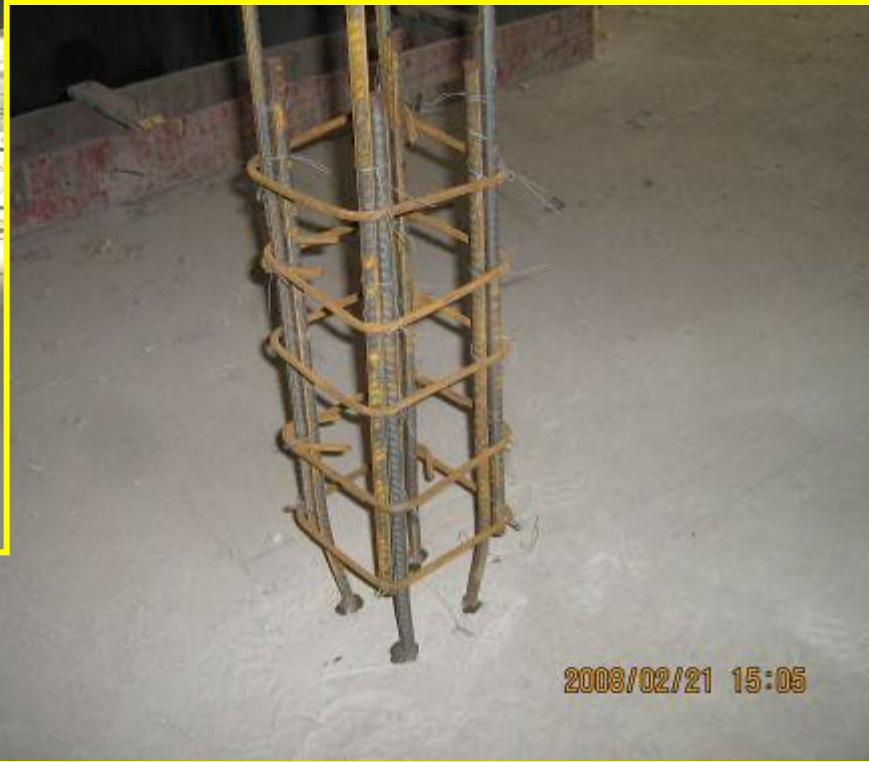
构造柱采用预埋钢筋时，应确保钢筋留设长度满足搭接要求。
