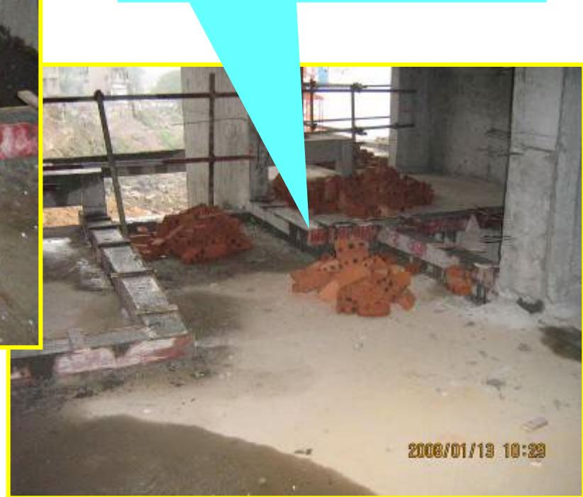
●所有预制过梁必须严格按设计图集及相关规范要求进行制作，制作完成后用墨汁标注上下方向，避免安装过程中钢筋位置反向
