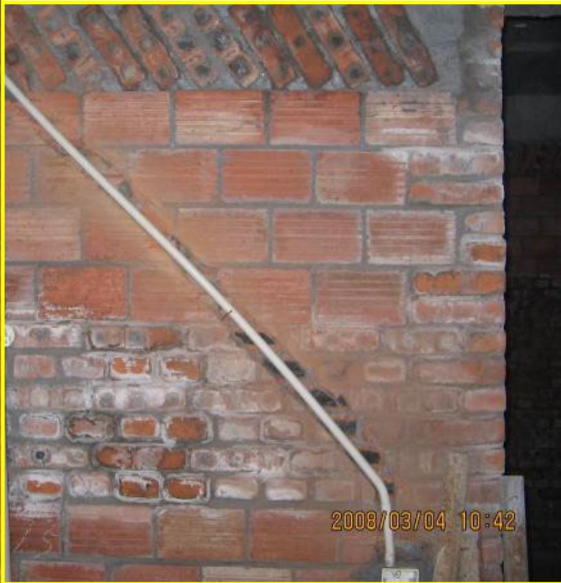
线管敷设弯曲半径符合要求、尽量避免有直接、并固定牢靠
