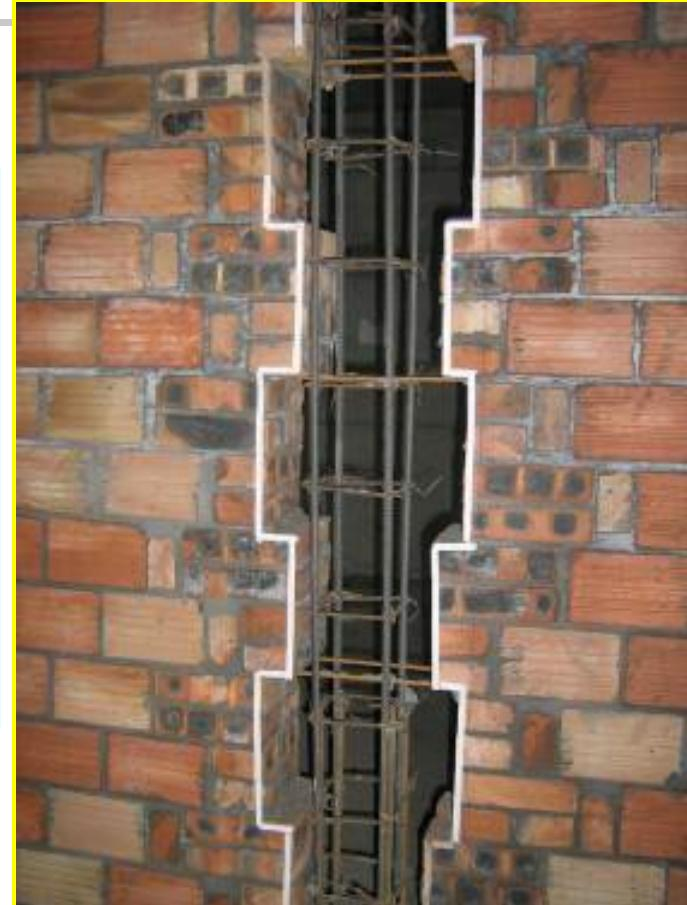
●构造柱模板必须采用对拉螺杆拉接, 构造柱上端制作喇叭口, 砼浇筑牛腿, 模板拆除后将牛腿剔凿。
