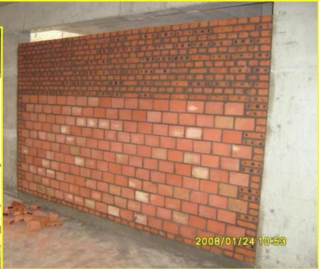
● 实心砖砌筑部位：构造柱边及L、T型墙转角实心砖；栏杆与后砌墙相交处砌实心砖
