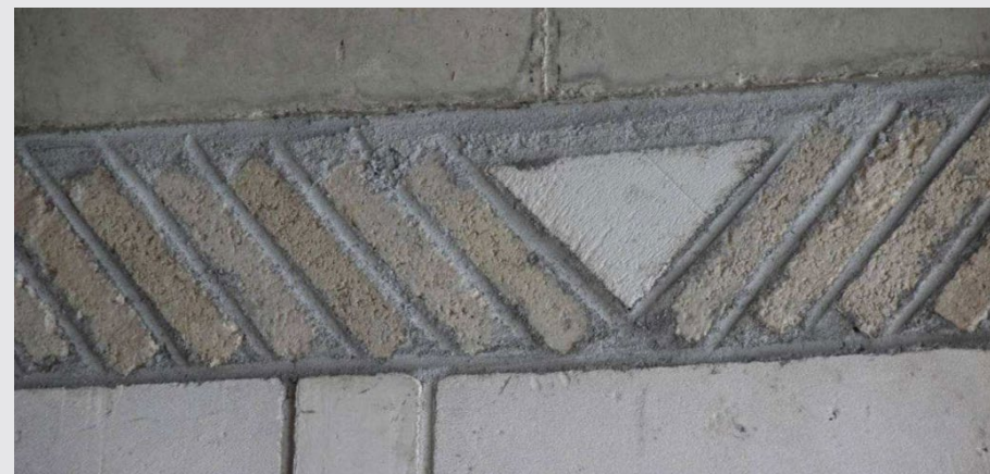
顶砌角度宜为 45^{\circ} ~ 60^{\circ} ; 倒八字、三角块设置到位
