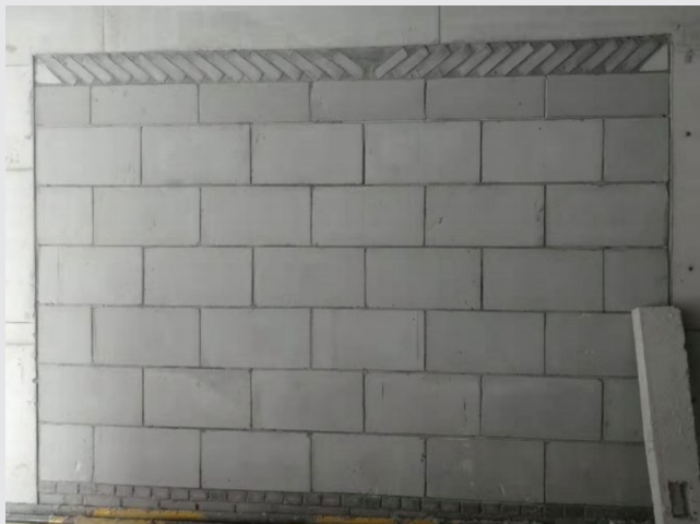
Fig.4 砌块、灰缝效果
