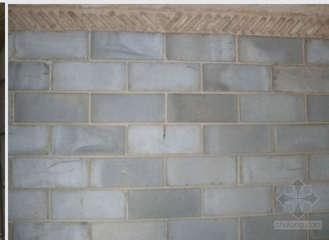
Fig.6 倒八字斜砌
