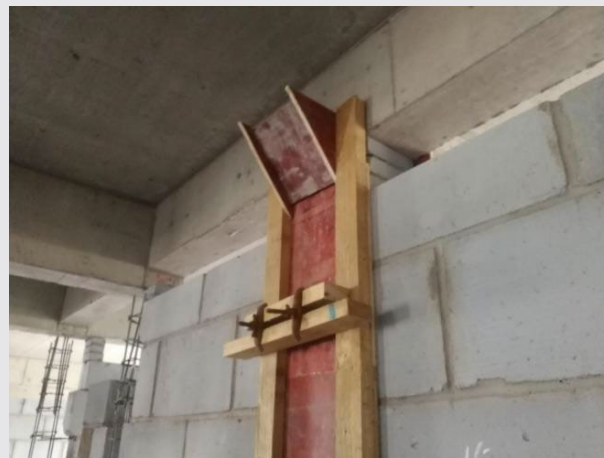
对拉螺杆加固、投料斗设置、成型效果
