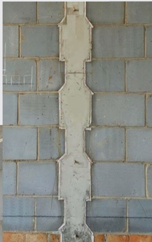
对拉螺杆加固、投料斗设置、成型效果
