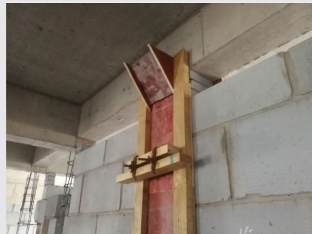
Fig.10 构造柱支模
