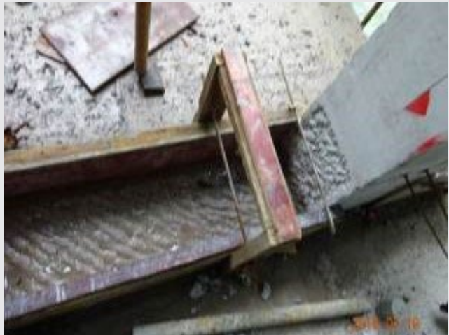
Fig.2 反坎二次浇筑
