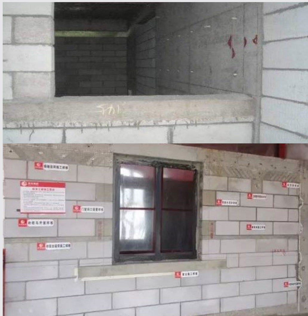
正确窗台压顶施工效果
