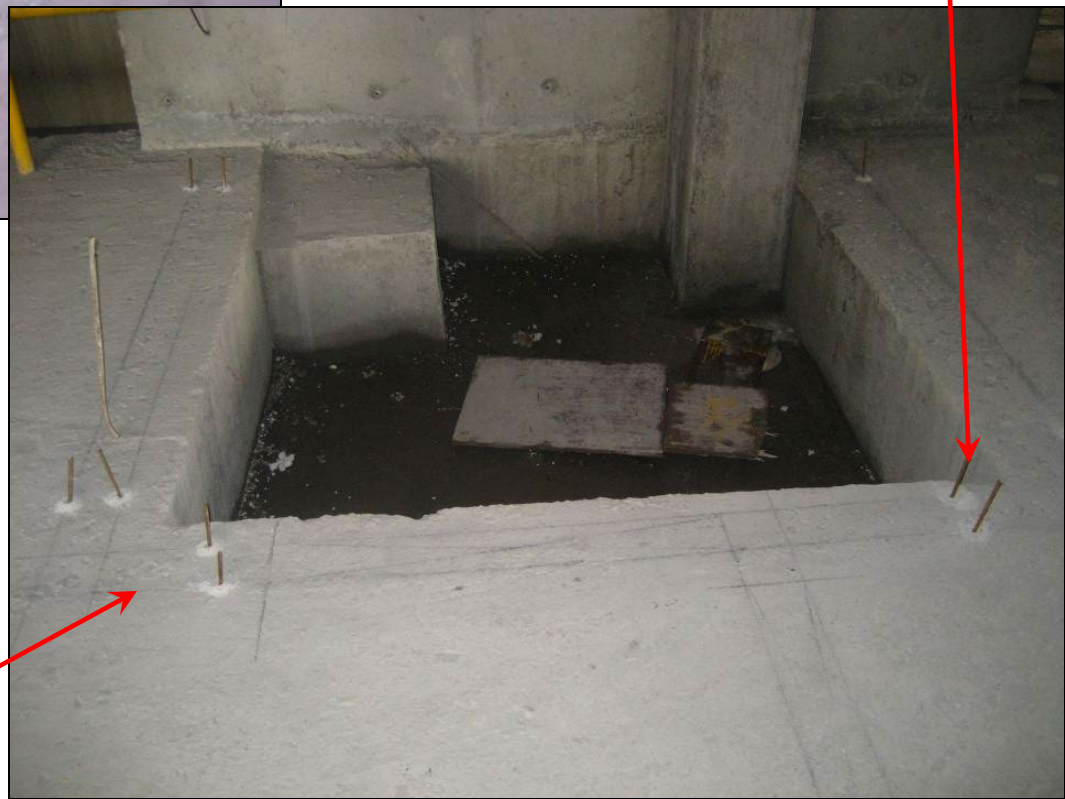
止水带模板定位钢筋
