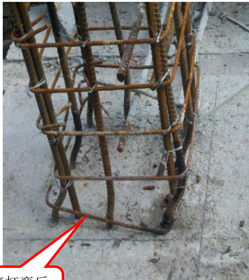
主筋打弯后 未重新植筋
