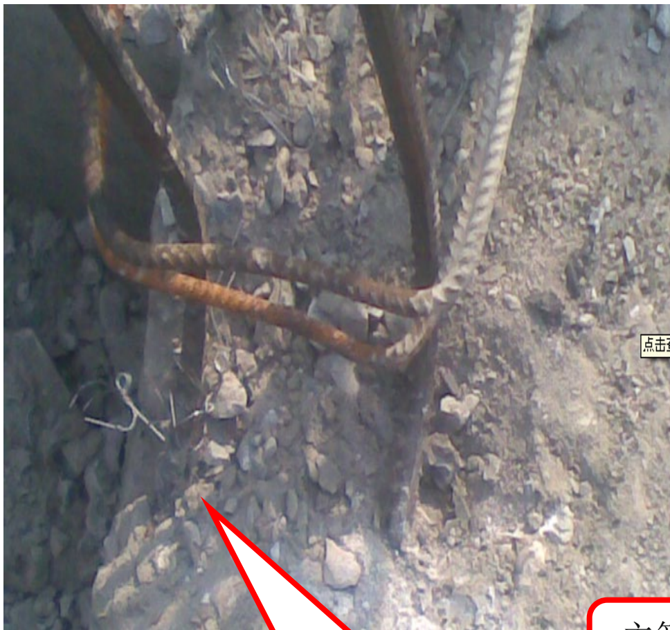
主筋打弯后 未重新植筋
