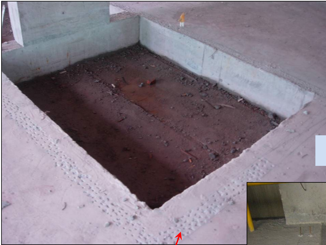
止水带模板定位钢筋
