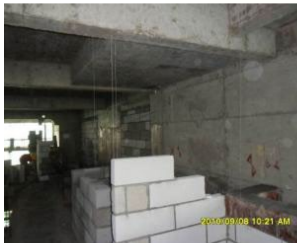
A46：砌筑过程中，每一皮砌块均应带通线，门窗洞处在上口放线。
