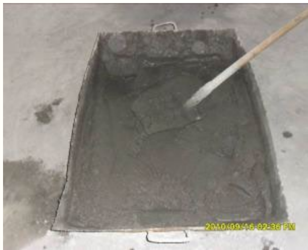
A72: 砌筑砂浆采用灰斗盛放，避免砂浆对地面的污染及减少砂浆材料浪费。 (与3.6工具一样)
