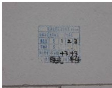
A71: 实测数据上墙，除了墙上盖相应的印章外，且应在原位上采用粉笔标出测量数据。
