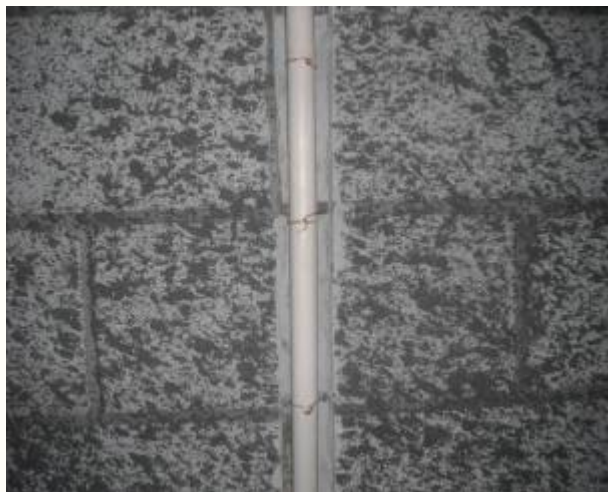
A65: 管线固定方式: 水泥钉 + 铜丝。
