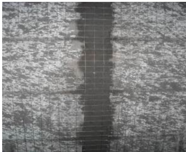
A66: 管线固定后, 采用干粉砂浆或CL30专用砂浆将线槽填平, 然后挂钢丝网, 规格 10\times 10\times 0.7\text{mm} , 每边宽度不小于100mm, 固定钉间距不超过300mm, 固定后保证钢丝网平整、连续、牢固、绷紧, 不变形起拱。
