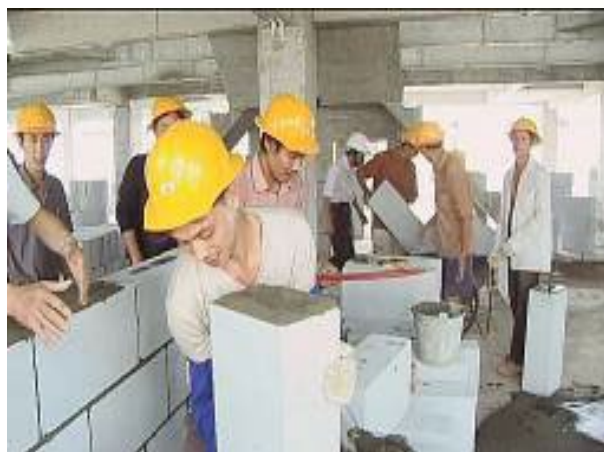
A42: 砌体的竖向灰缝应在砌块的一个端面敷浆，再抬高砌块40~60mm，让其坠落以墩实（或旁敲砌块2~3下）。
