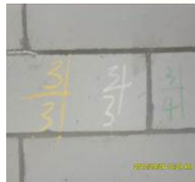
A71: 实测数据上墙，除了墙上盖相应的印章外，且应在原位上采用粉笔标出测量数据。
