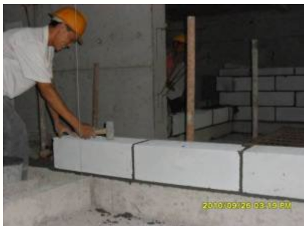
A41: 第一皮砌块必须严格按照皮数杆、控制线精确定位。
