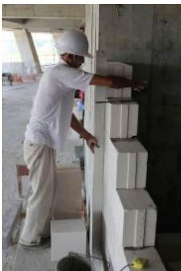
A43：砌筑过程中班组进行自检工作以便进行及时整改
