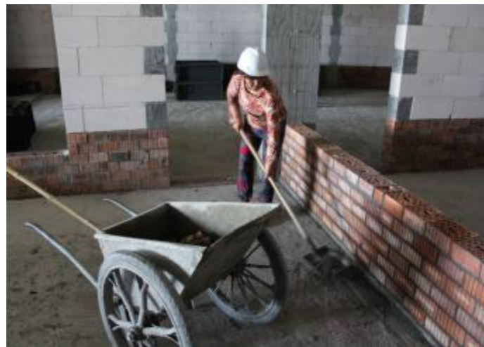
A73: 砌筑过程中，砌块材料堆放整齐；砌筑完成后，当天将破损的砖块、落地灰清理干净，做好“落手清”工作。
