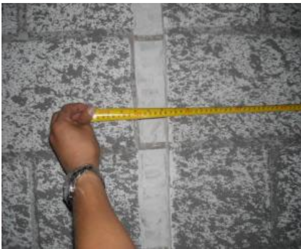
A64: 管线开槽应采取机械切割, 尺寸要求: 线槽深度 \leq d_n + 20\text{mm} , 线槽宽度 \leq d_n + 60\text{mm} ; 严禁开凿横槽长度大于390mm。
