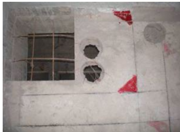
A31: 管道井、烟道也须设置双线，成品烟道和水电预留孔，在结构施工阶段，须放线定位。
