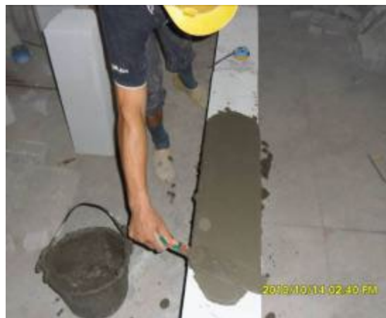
A44：砌体水平面敷浆要饱满，严禁将敷浆面的中间刮成凹状（容易导致水平灰缝空心）。
