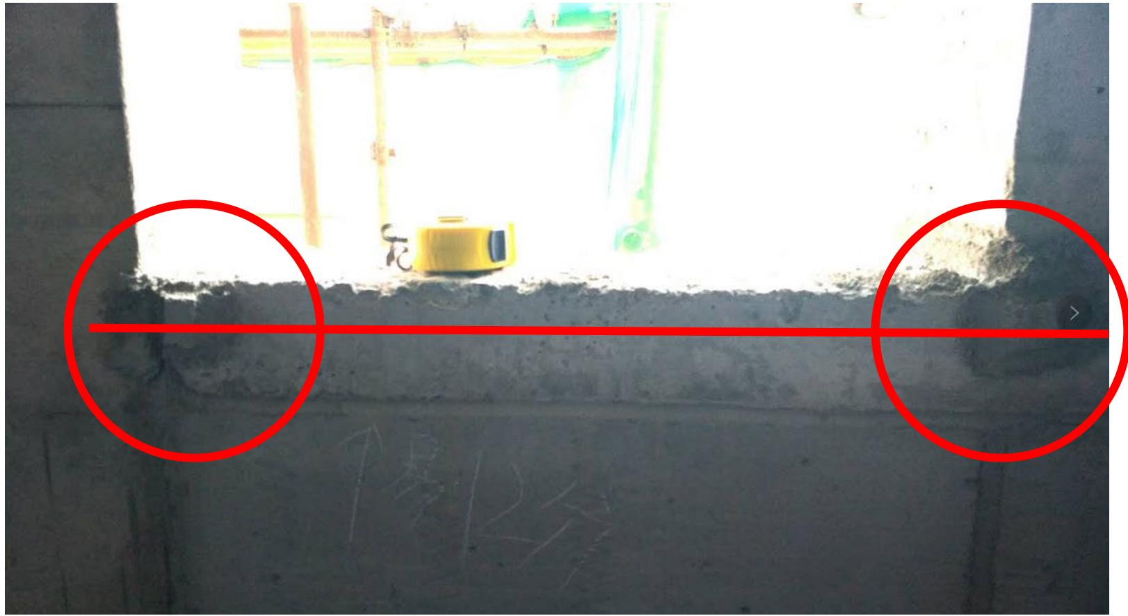
**窗两边对称打灰饼，灰饼在同一高度，有助于外窗内侧收口**
