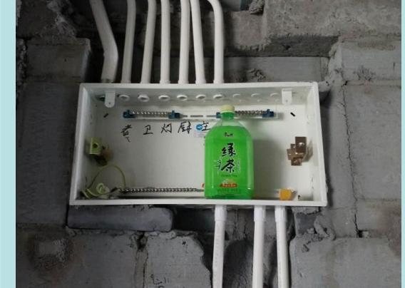
用激光水平仪以控制线（20mm线）与灰饼相结合控制线盒出墙面安装高度；
