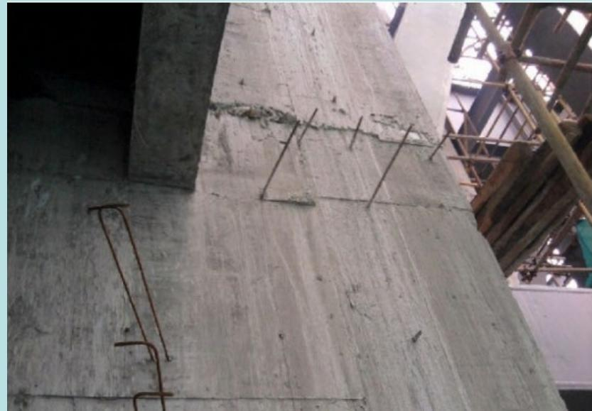
螺杆洞口封堵，外侧涂刷JS防水涂料
