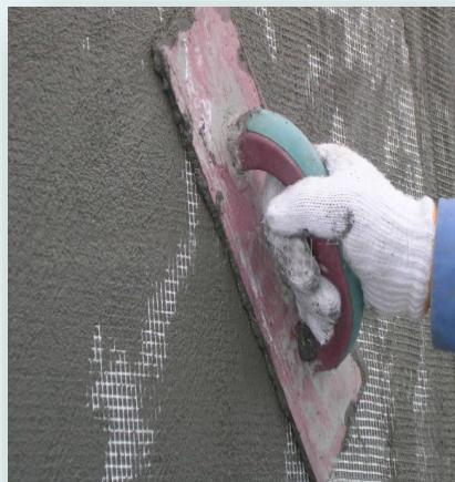
待底灰稍微干一点时，罩面灰用木杠刮找平整压入玻纤网用木抹子搓平。
