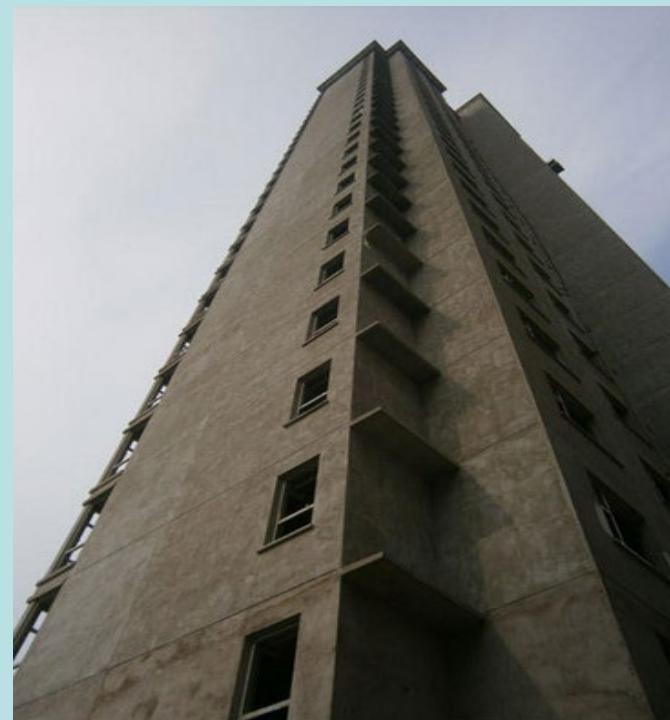
外墙抹灰完成后一定要保证抹灰面平整，大阳角竖直，窗洞口上下一条线；
