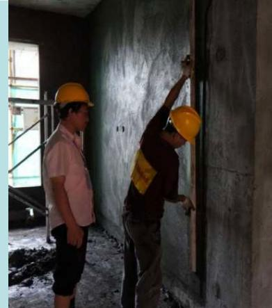
抹灰前应先抹一层底灰，当墙面凹度较大时应分层衬平。每层厚度不大于5~7mm。抹时用力压实使砂浆挤入细小缝隙内，接着用木杠刮找平整。
