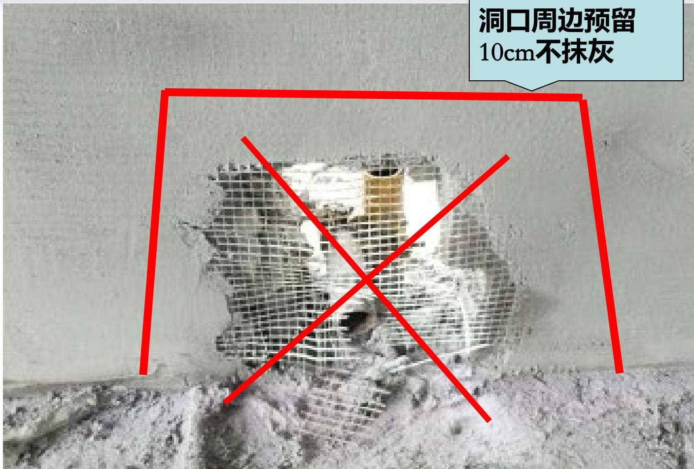
施工洞口、门窗洞口、后置箱体洞口处满挂加强网，抹灰界面距洞口边留设10cm宽，与洞口最后一次抹灰收口。
