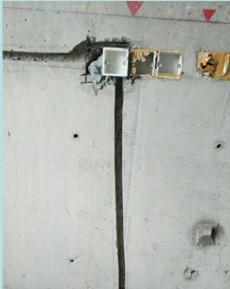
水电开槽要用专业的开槽机械，开槽深度大于线管直径10mm，开槽线规规矩矩；
