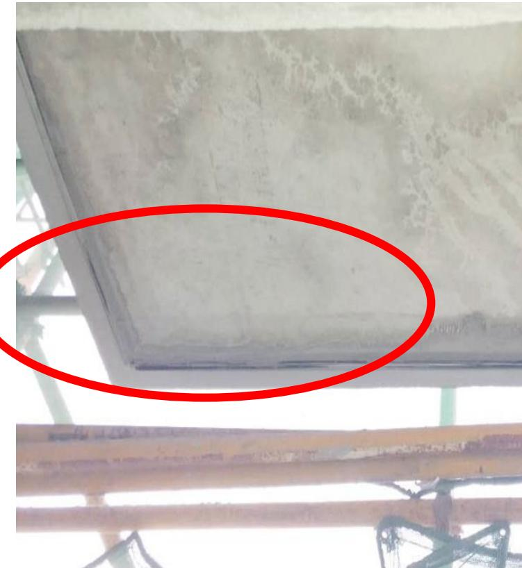
**挑板、挑檐、阳台、雨棚、檐口、门窗楣、外窗台、门廊等底部以及突出外墙的所有装饰线条都要设滴水线，本项目采用成品滴水线，尺寸宽20mm厚10mm**
