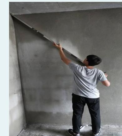
然后全面检查阴阳角是否方直、整洁，阴角交接处、墙顶板交接处是否光滑平整、顺直。并用托线板检查墙面垂直与平整情况。抹灰面接槎应平顺。
