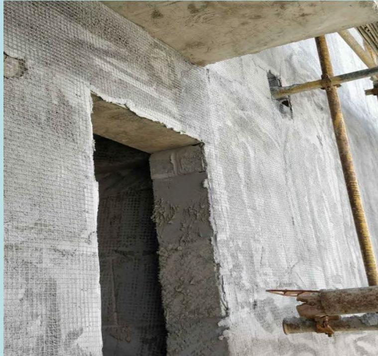
抹灰前一夜洒水润湿墙面，10厚1: 2.5水泥砂浆找平层打底灰；
