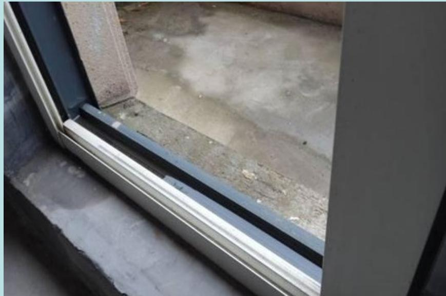
外窗台及雨棚飘檐（向外找坡）、压顶（向内找坡）坡度大于5%，严禁倒坡；外墙防水砂浆应翻包至门窗外框，阳角处预留加强网片长度翻包至外框。
