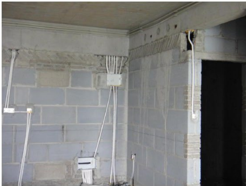
2、线槽等也使用石膏抹灰材料封堵
