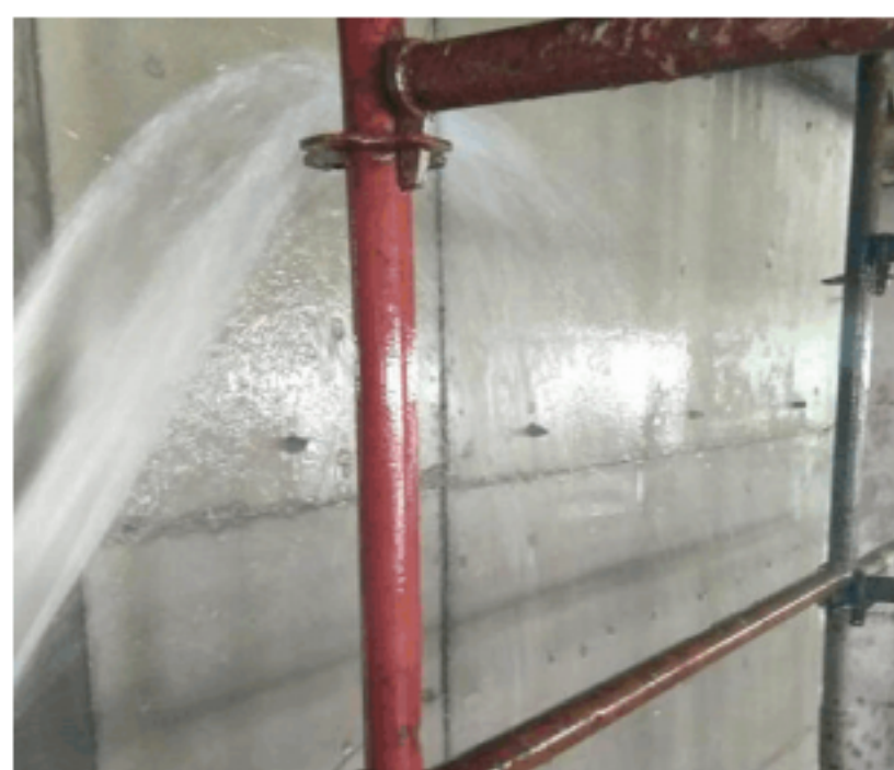
图 7-2 混凝土洒水养护
