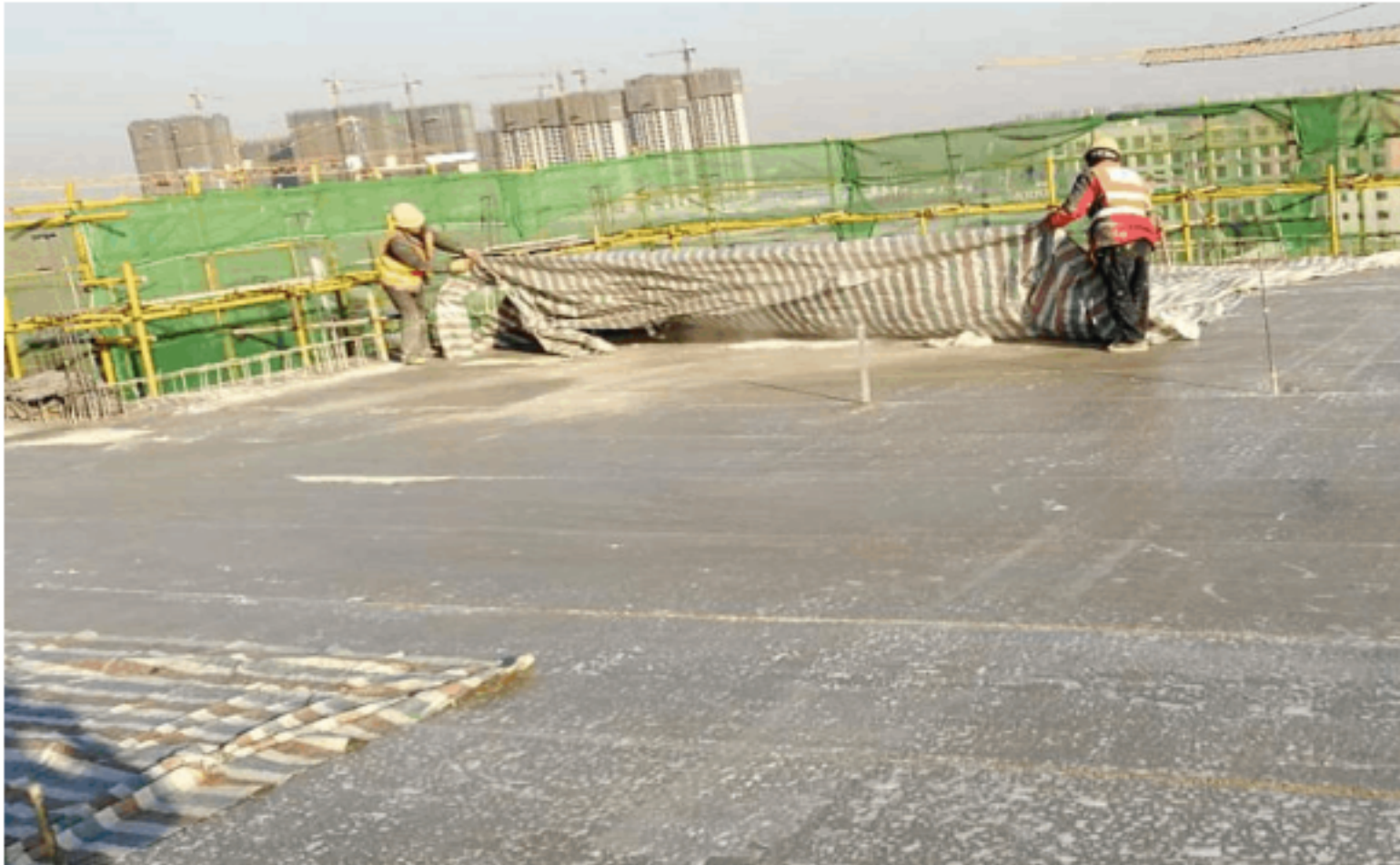
图 7-3 混凝土覆盖养护
