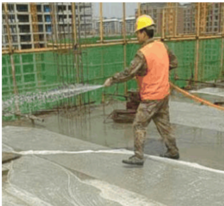
图 7-2 混凝土洒水养护
