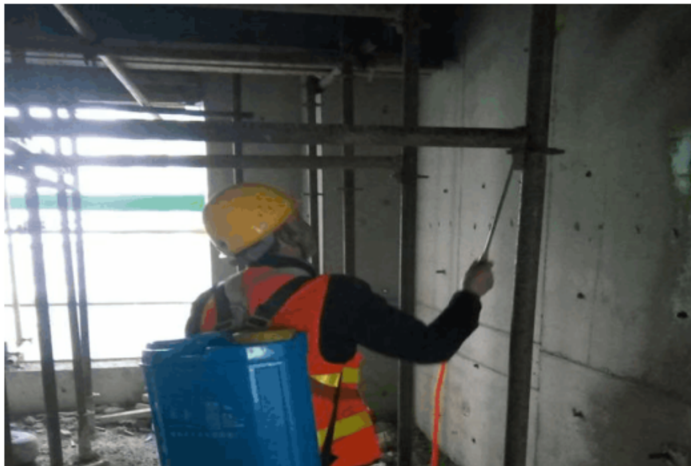
图 7-4 混凝土喷涂养护
