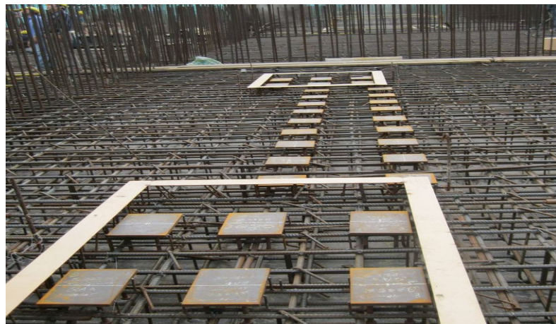
结构板预埋件安装
