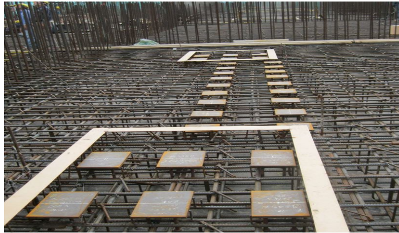
结构板预埋件安装
