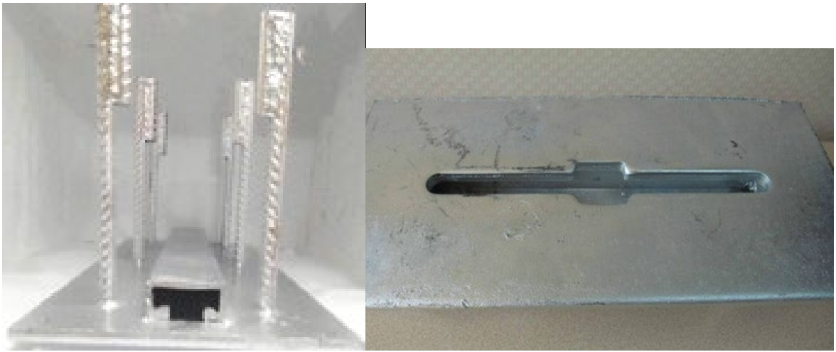
“板槽式埋件”侧面与正面照片
