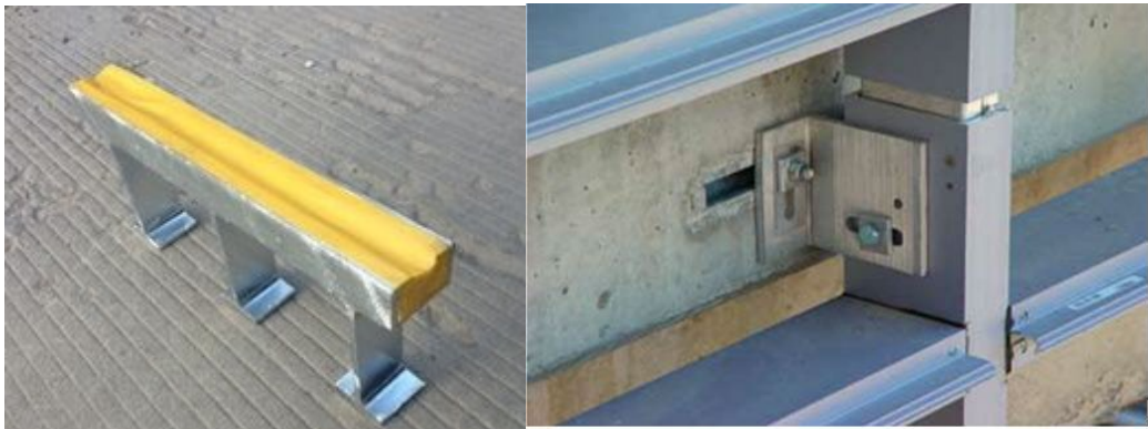
槽口封闭照片与施工完成后效果
