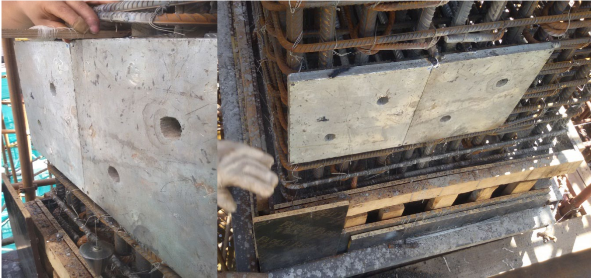
板式埋件“铅锤吊线法”与安装效果图
