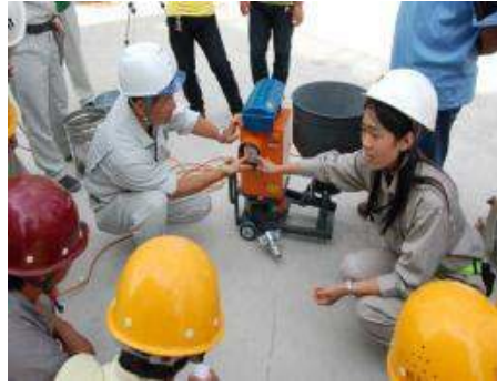
灌浆现场技术交底
