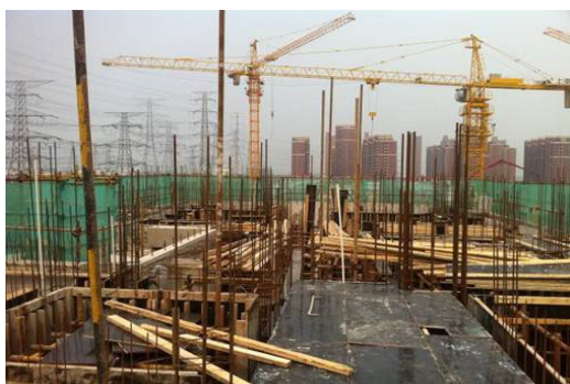
楼面、梁模板安装施工
