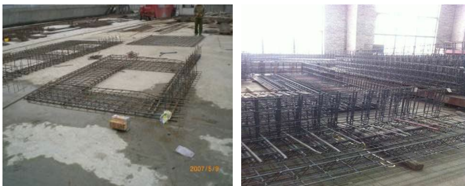
钢筋加工制作实况照片
