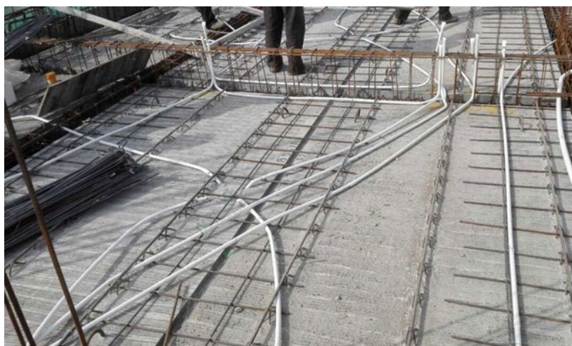
叠合板钢筋绑扎
