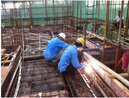
模板安装完成，楼板钢筋绑扎、 线预埋
