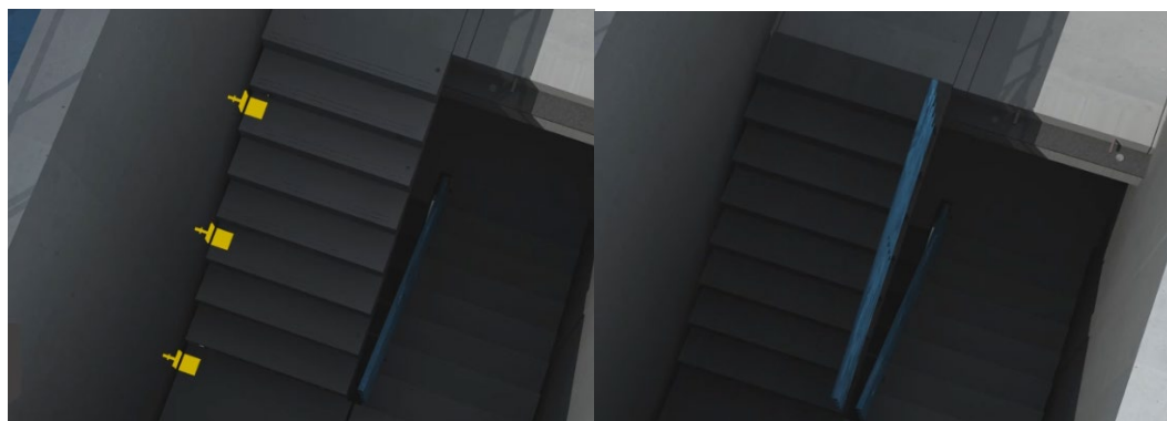
安装预制楼梯与墙体之间的连接件
