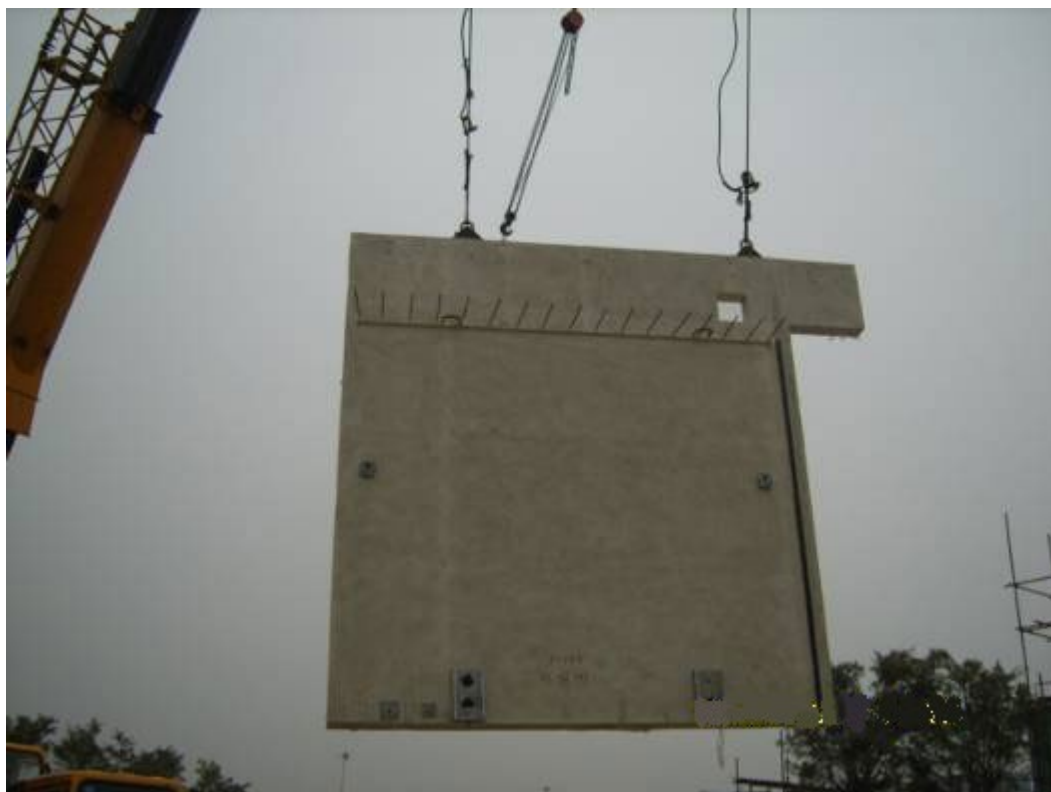
墙板吊装示意图
