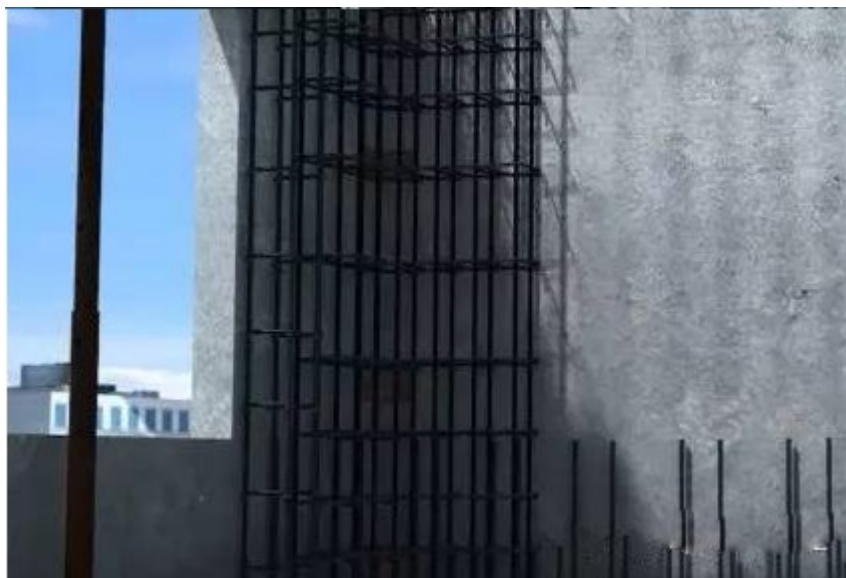
6、电梯井道内模板安装。
