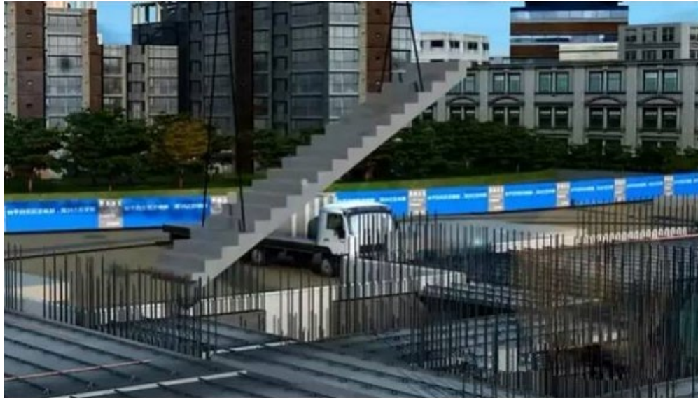
11、工作面安装安全防护措施。
