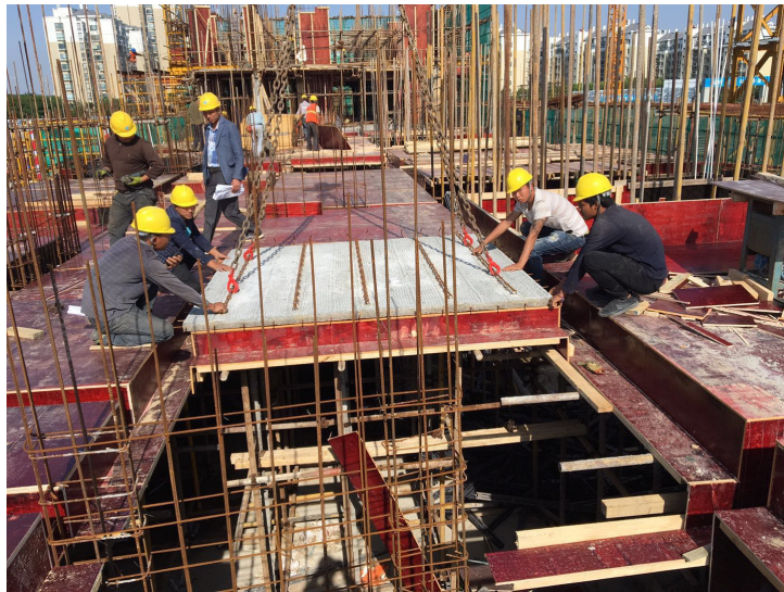
2.5 叠合板、阳台、楼梯按吊装顺序逐次吊装。
