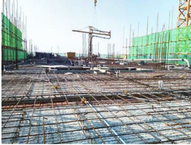
2.7 楼层砼浇筑捣并养护
