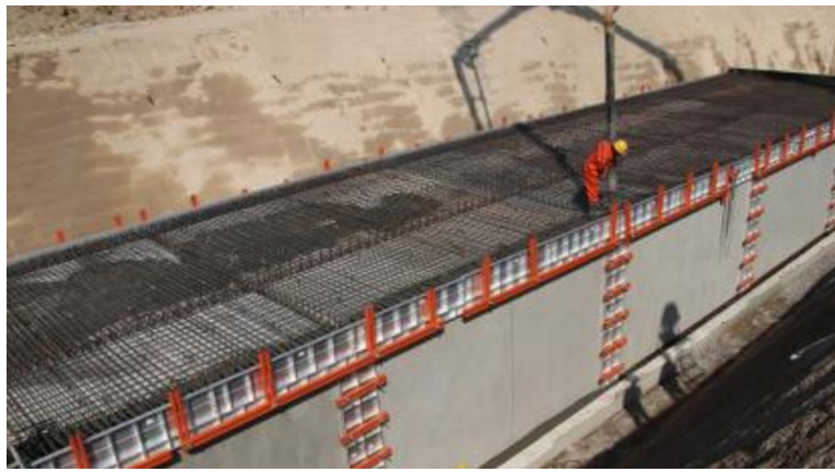
2.8 重复以上工序，进行上一楼层施工，并进行本楼层套筒灌浆作业。
