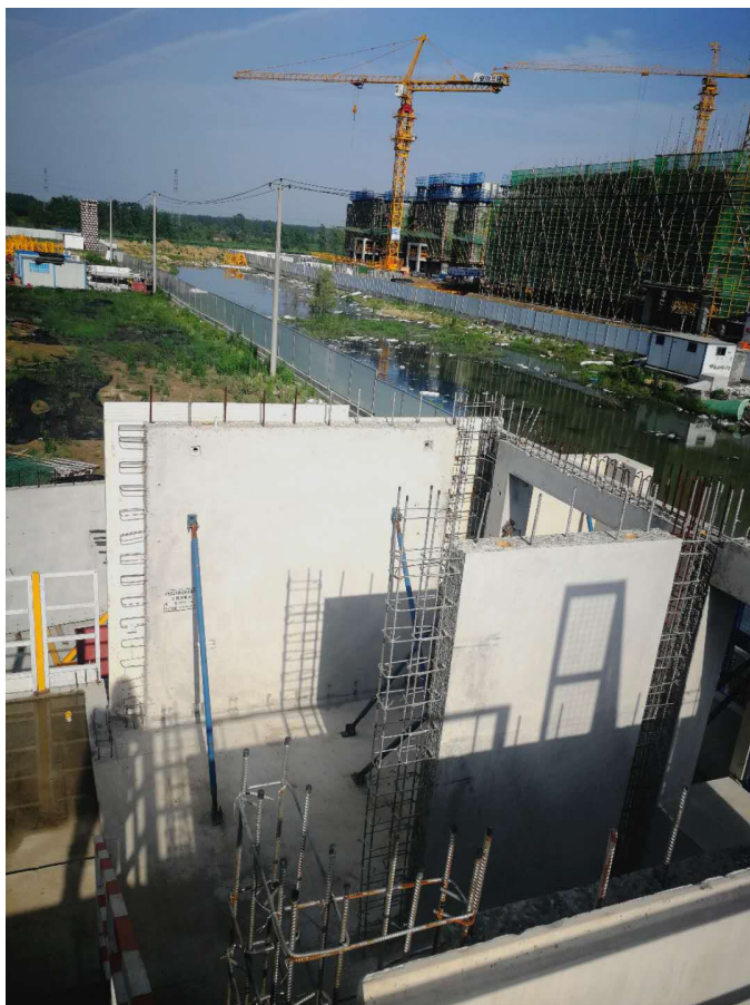
2.4 剪 支模，叠合板竖向支撑搭设，标高复核。
