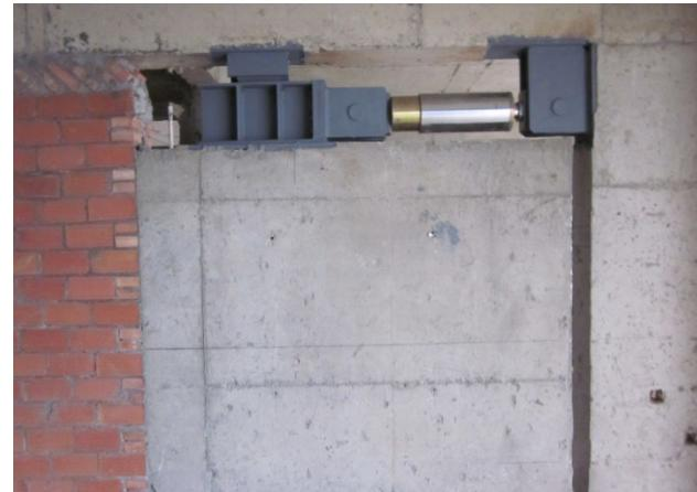
采用硅油作为介质，通过小孔激射原理实现阻尼特性。从工作原理，阻尼结构设计、产品的寿命和可靠性，相比以往类型的阻尼器均发生了革命性变化，代表着当前粘滞阻尼器技术发展的最高水平。下面一起来看看粘滞阻尼器的安装方式：
