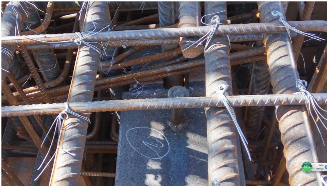
柱纵向钢筋通过预埋件示意图
