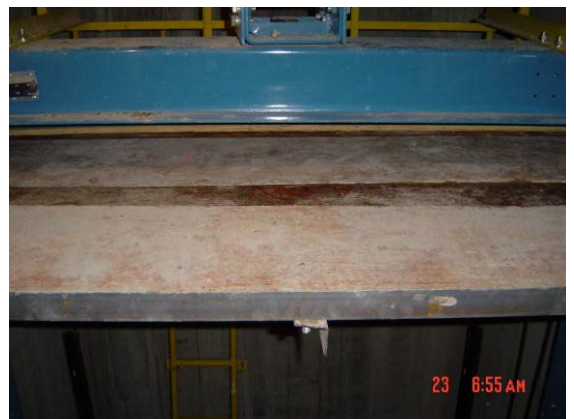
模板铺满平台
