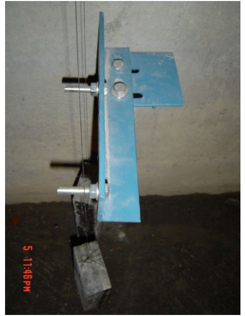
对重导轨样线
