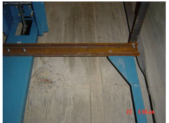
支撑杆支撑住8号槽钢
