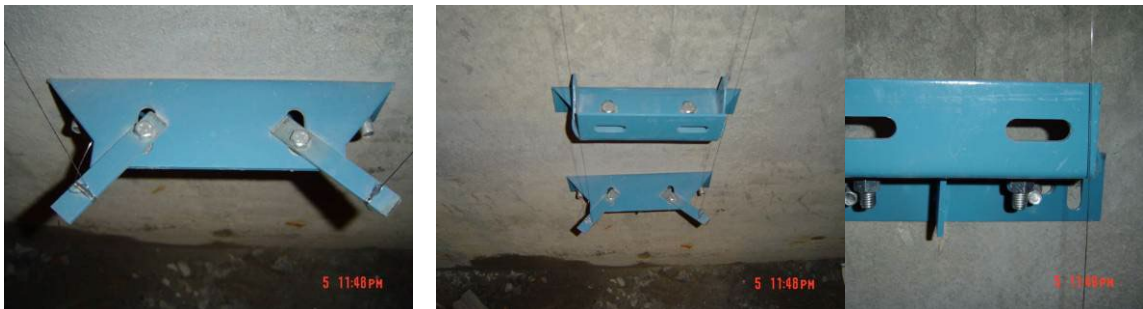
轿厢导轨样线定位
