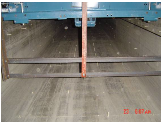
5×5角铁固定在槽钢上
