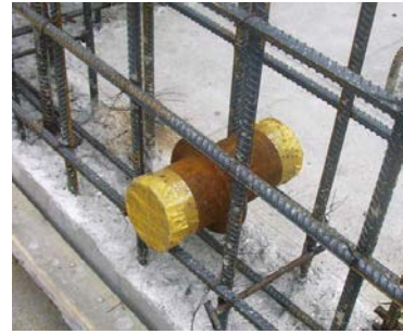
出砼的电气配管保护
