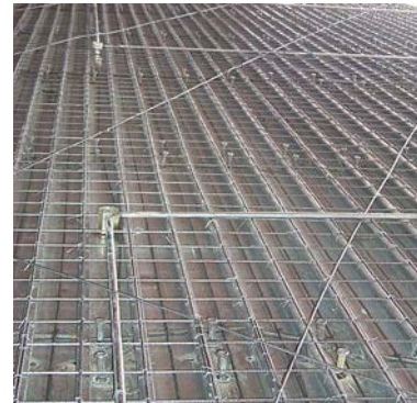
顶板内电气配管及盒保护
