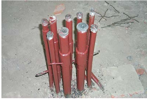
墙体预埋套管口保护
