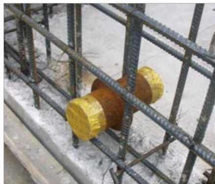
墙体预埋套管口保护
