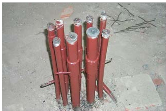
顶板内电气配管及盒保护
