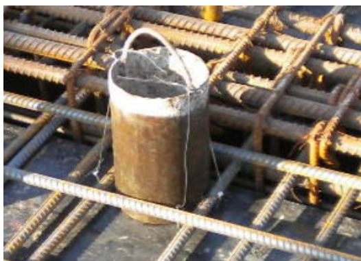
钢套管在混凝土浇筑后需及时取出
