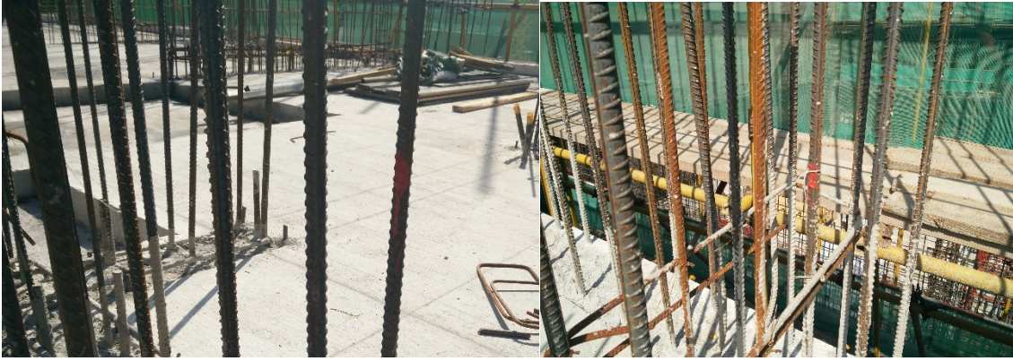
结构洞口两侧测设标高控制点
