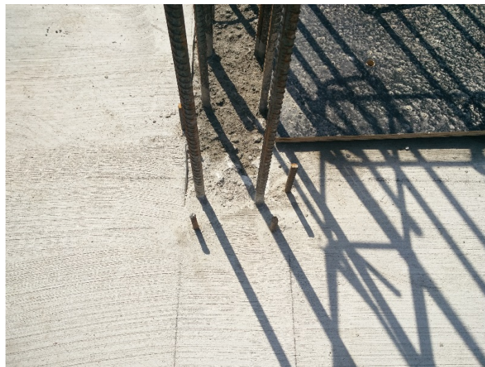
楼面设置洞口模板定位钢筋
