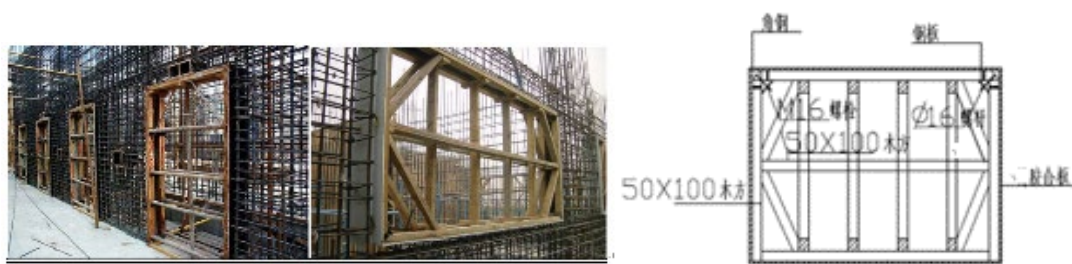
门窗洞口模板示意图(木模板)
