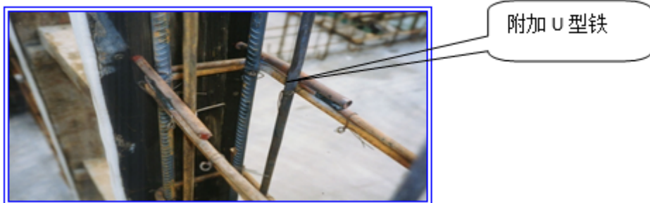
门窗洞口模板定位钢筋示意图
