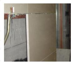
时利用可调余量调回。成孔要求与结构表面垂直,成孔后把孔内的灰粉用小勾勺掏出,安放膨胀螺栓,宜将本层所需的膨胀螺栓全部安装就位。
