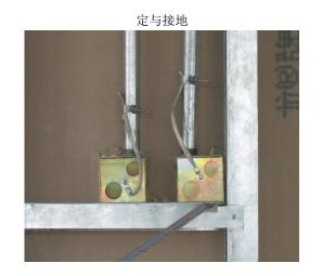
4) 明配管时管路布置要按照横平竖直、注重观感的原则,空间布置要合理。管路要弹线定位,在任意 2m 段配管平直度和垂直度偏差不大于 3mm,全长偏差不应超过管子内径的 1/2。
