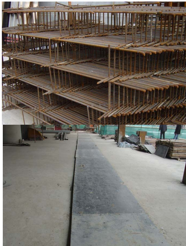
图 18.2-2 利用短的废旧钢筋焊接马凳
