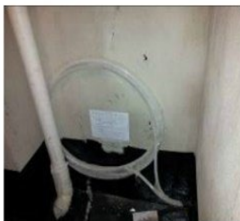
卫生间预留地热管线
