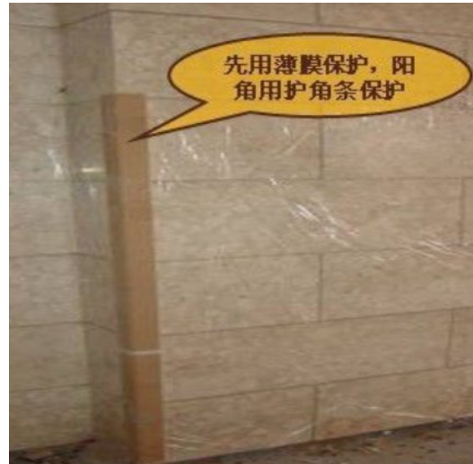
施工完成后的阳角保护
