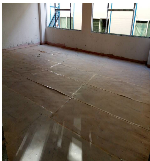
地砖铺贴成品保护措施
