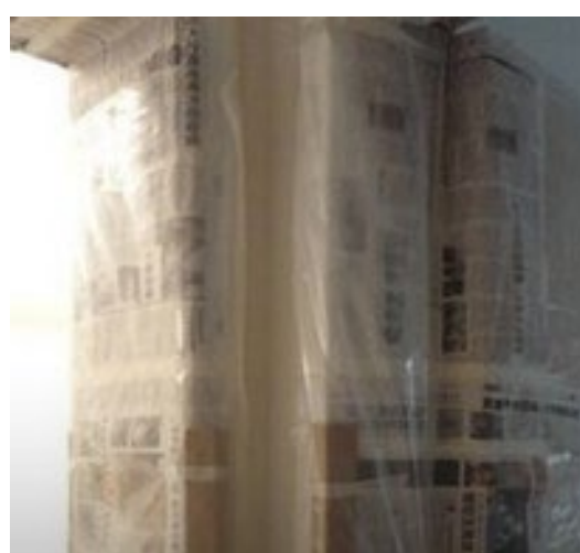
木门安装成品保护措施
