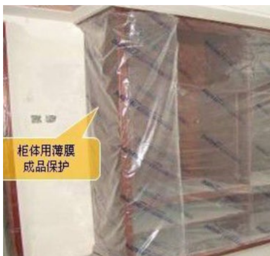
柜体安装成品保护措施
