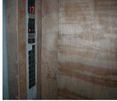
2)、门套保护。电梯门套及电梯厅过道门套用木模板满包。
