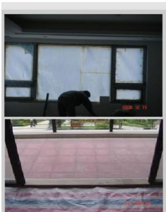
2)、拆搭脚手架、跳板其材料对铝框要有相应的保护措施，否则不许在门窗框上拖，安装管线，设备应防止撞坏幕墙。
