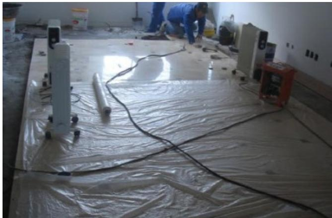
3)、对在已完成的地面上进行其他施工的工器具要进行安装橡皮垫等保护材料，以免碰伤地面成品。
