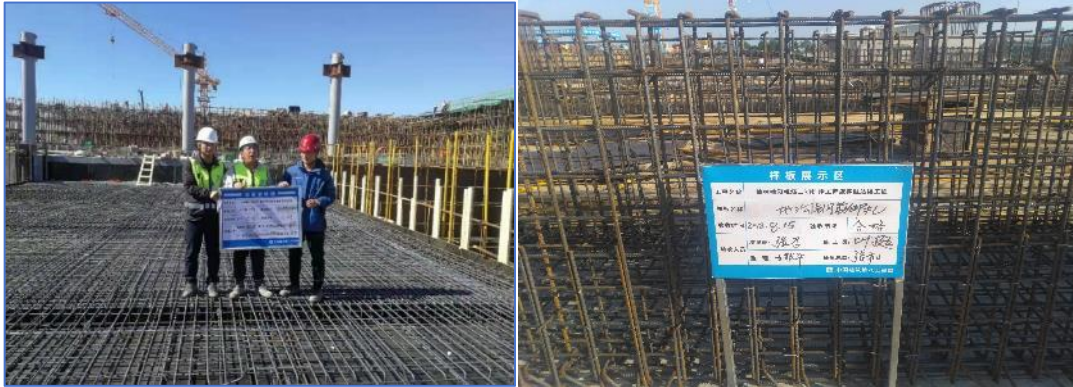
图 1.1.1-10 钢筋样板验收示意图
