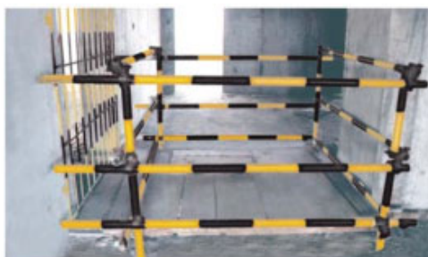
预留洞口防护应用示意图
