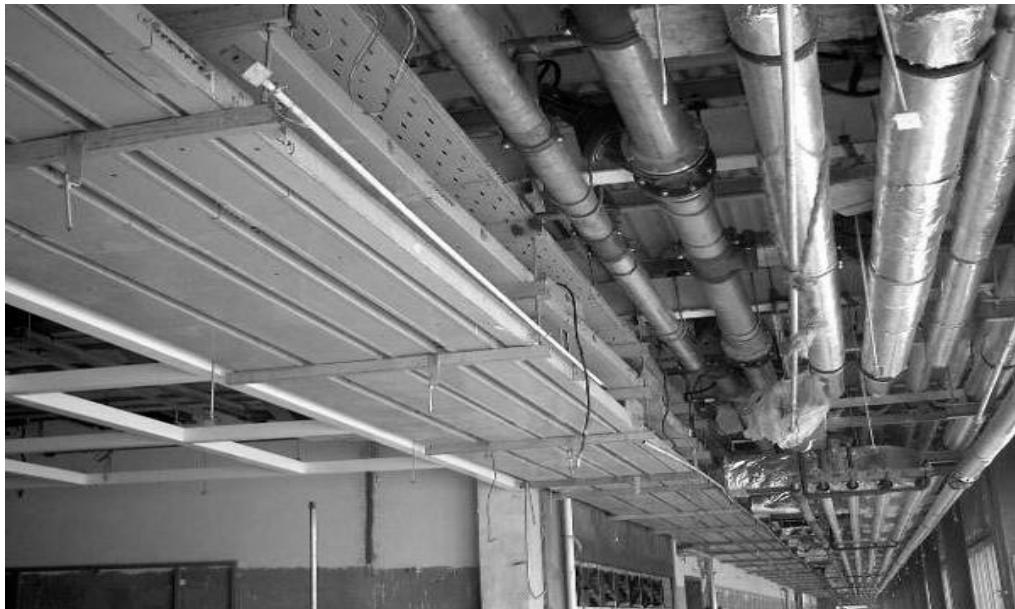
以免出现段与段之间连接困难和影响管路整体性能及感观效果，接头部位应设有支撑点。
