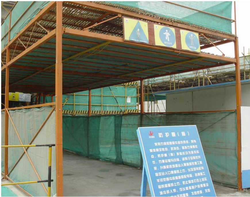
型钢制作的安全通道防护
