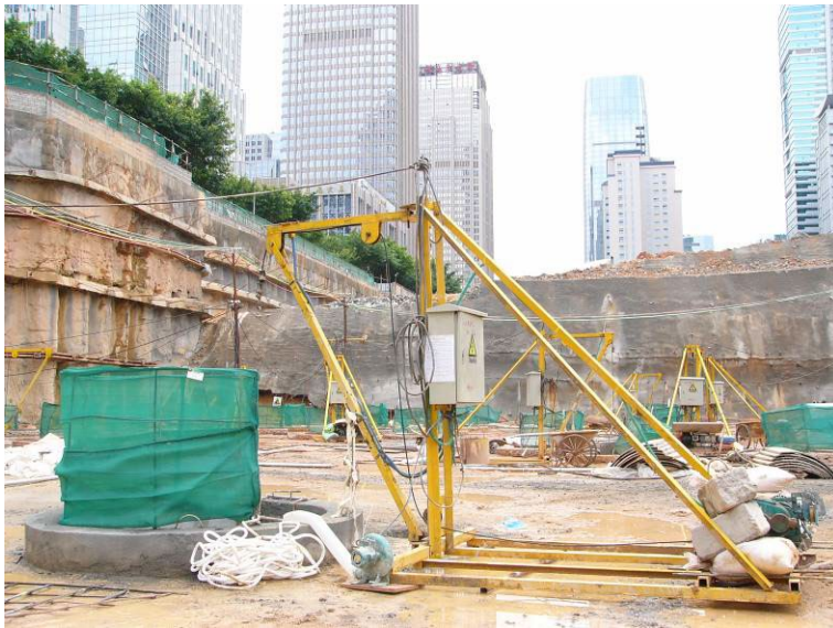
卷扬机必须有压重、井下必须有通风系统
