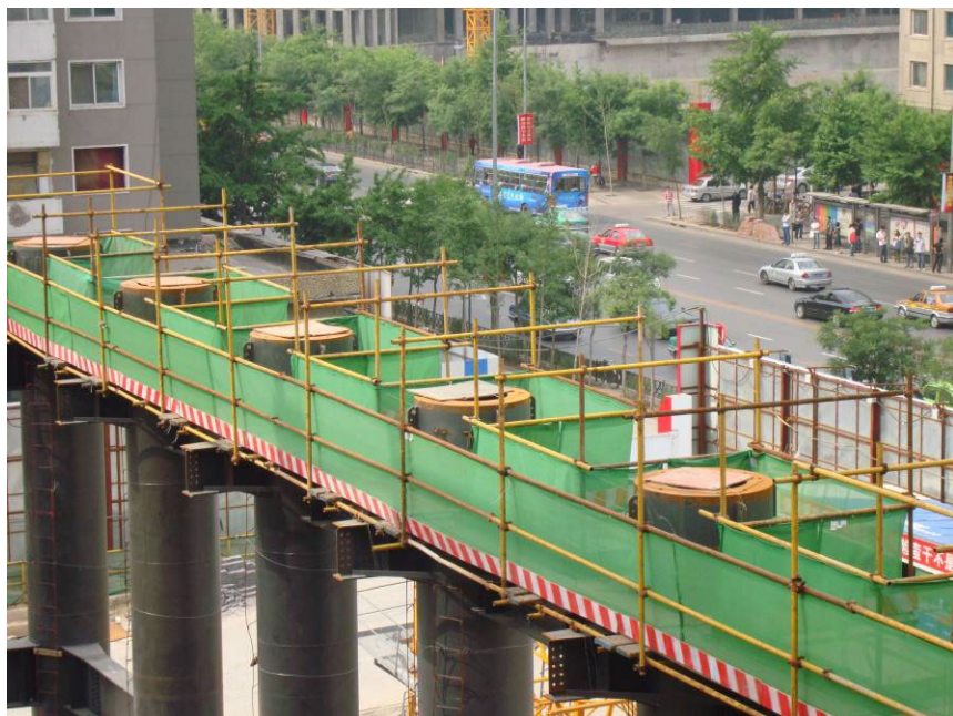
钢结构作业防护搭设示意图
