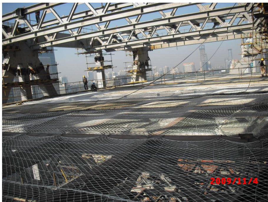
钢结构中安全平网的铺设
