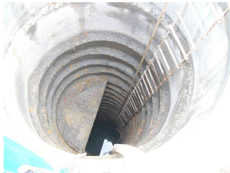
人工挖孔桩井底作业人员防护和软爬梯
