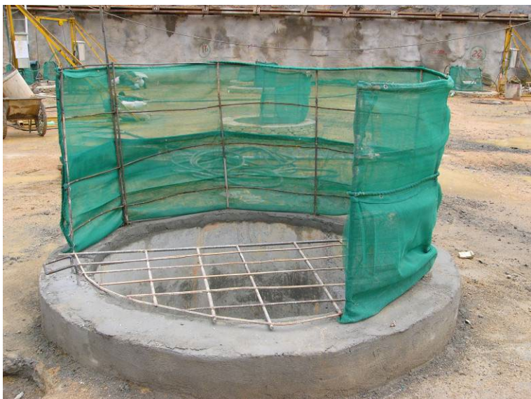
人工挖孔桩井口防护
