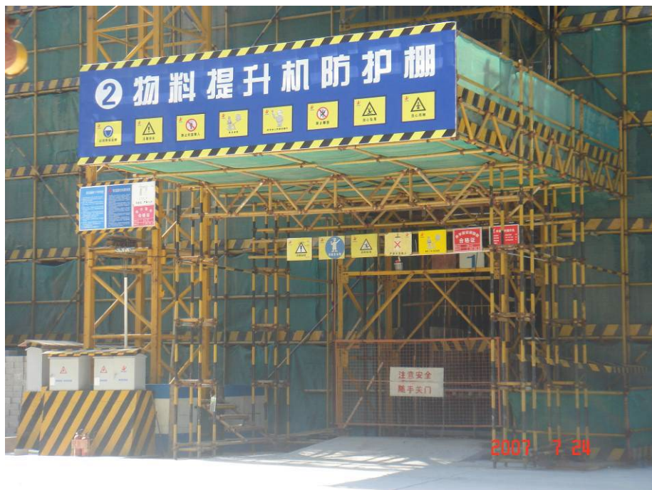
施工机械进出口防护
