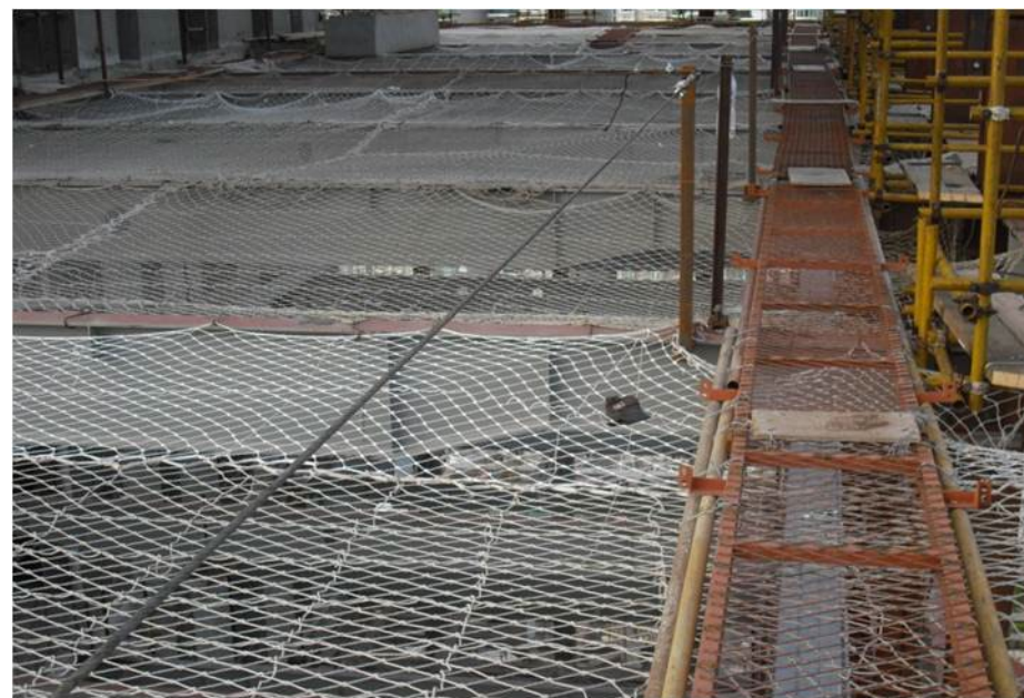
钢结构作业走道防护搭设示意图
