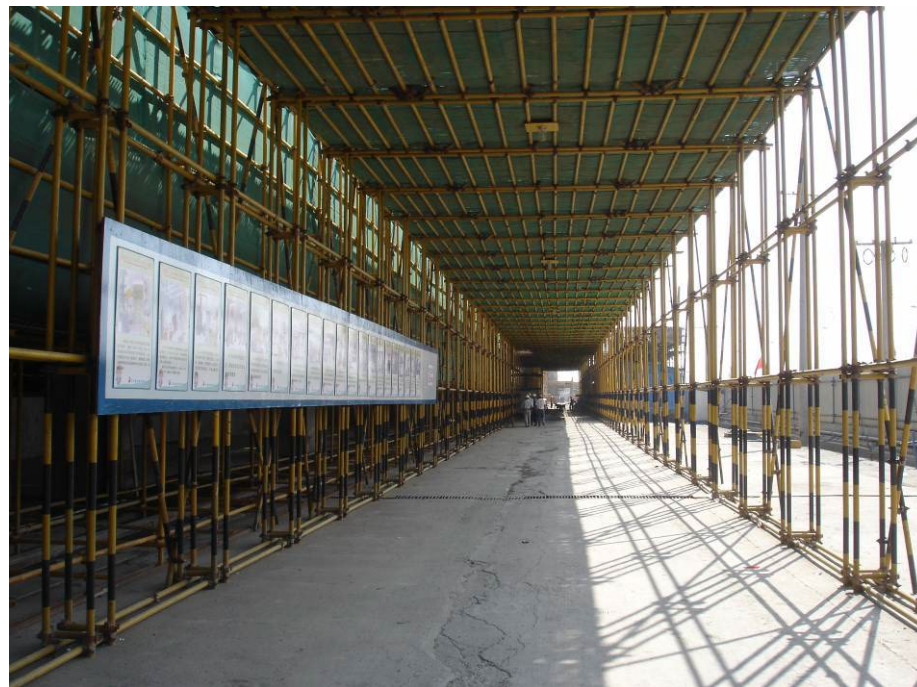
钢管搭设的安全通道防护
