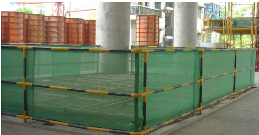
边长在 150cm 以上的洞口的防护
