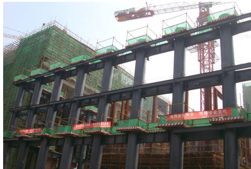
钢结构作业防护搭设示意图
