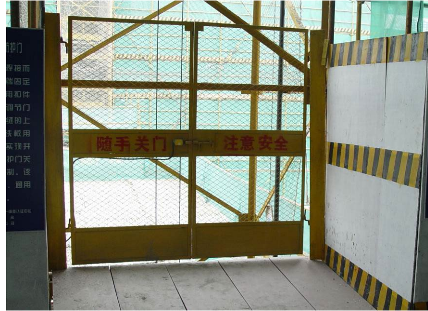
垂直运输设备层门及通道防护
