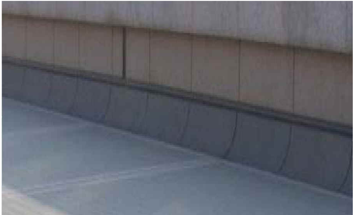
女儿墙与防水屋面交接处
