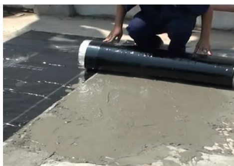
大面铺贴 BAC 防水卷材
