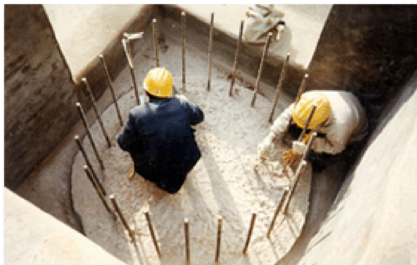
（地下室桩头部位涂刷水泥基渗透结晶）
