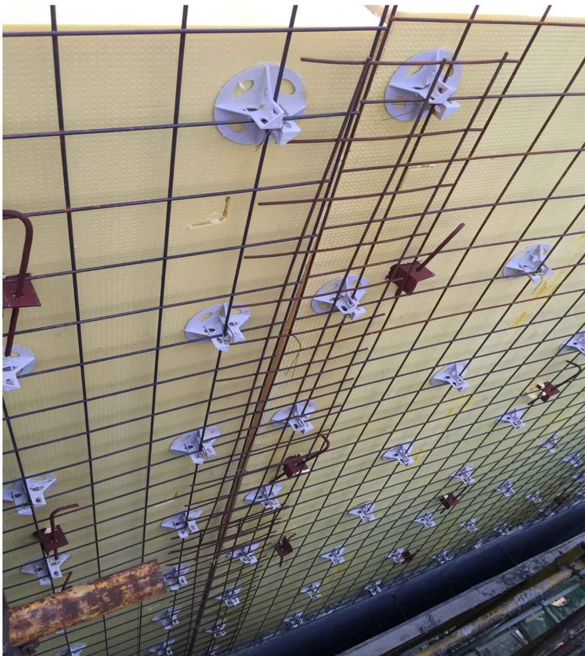
5.2.2)角网放置到保温板的阴阳角，用扎丝绑扎到保温板铁网上。(图3)
