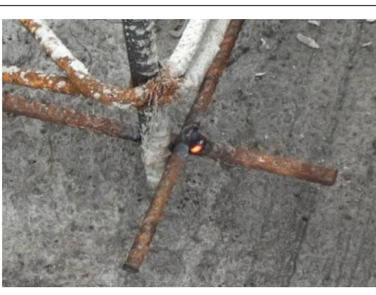
2. 定位钢筋：采用 \Phi 16 钢筋（端部平整），离地面高度80mm，水平距离800mm一个，焊接后端部与墙定位线平，误差 \leq 1\text{mm} ；
