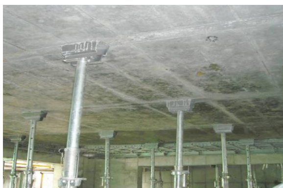
19. 楼面模板拆除：早拆头—龙骨—楼板—阴角模—支撑；阴角板拆除先拆带斜边的角模；
