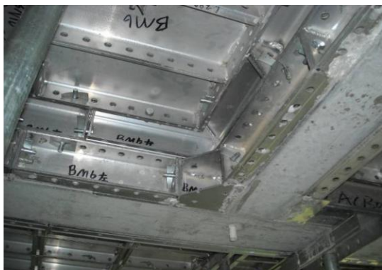
18. 梁模拆除：先拆底模再拆侧模，立杆保留；
