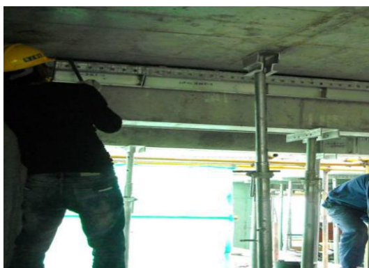
19. 楼面模板拆除：早拆头—龙骨—楼板—阴角模—支撑；阴角板拆除先拆带斜边的角模；
