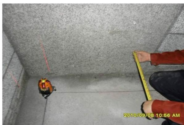
门洞侧面、顶面利用砌筑门洞中线，采用扫平仪进行灰饼定点，
