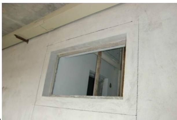
抹灰完成后在墙面弹出建筑 1m 线，便于地坪、门窗、机电、顶棚各专业使用。
