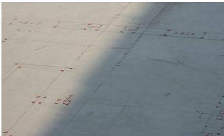
②结构放线采用双线控制，控制线与定位线间距按照 200mm 引测；轴线、墙柱控制线、周边方正线在混凝土浇筑完成后同时引测
