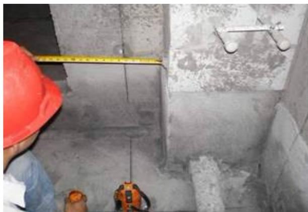
门窗洞口二次收口弹控制线 150mm，保证门窗侧面和顶面方正顺直
