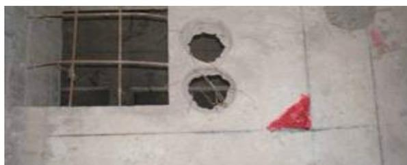
将建筑控制线翻到砌体墙上，土建将建筑 1m 线移交给机电专业以便于机电预埋进行精确定位。
