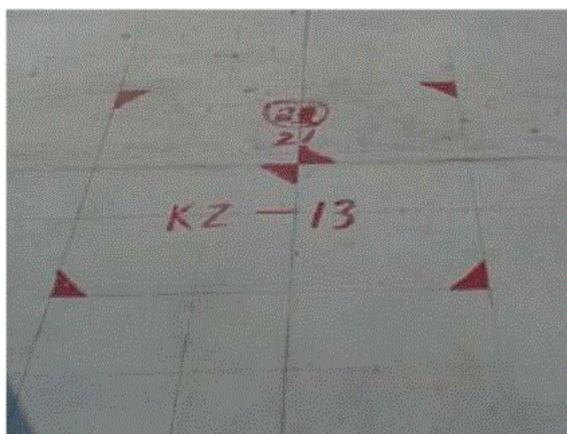
在首层控制点上架设激光铅垂仪，调置仪器对中整平后启动电源，使激光铅垂仪发射出可见的红色光束，投射到上层预留孔的接受靶上，查看红色光斑点离靶心最小点，将仪器旋转 4 个 90° 画圆，将 4 点连成十字，其中 0 点即为圆心，此点即作为第二层上的一个控制点，其余控制点可用同样的方法向上传递，弹出控制线。
