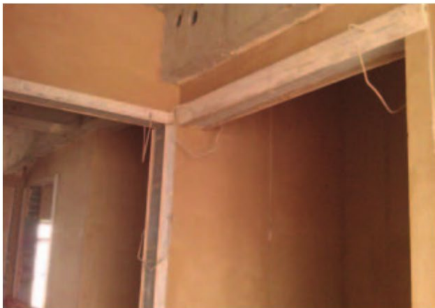
15、门窗洞口阳角用夹具施工
