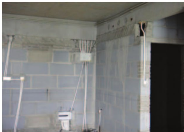
2、用适莱轻质抹灰石膏回填线槽
