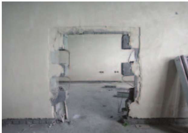
16、施工洞口用两层网格布
