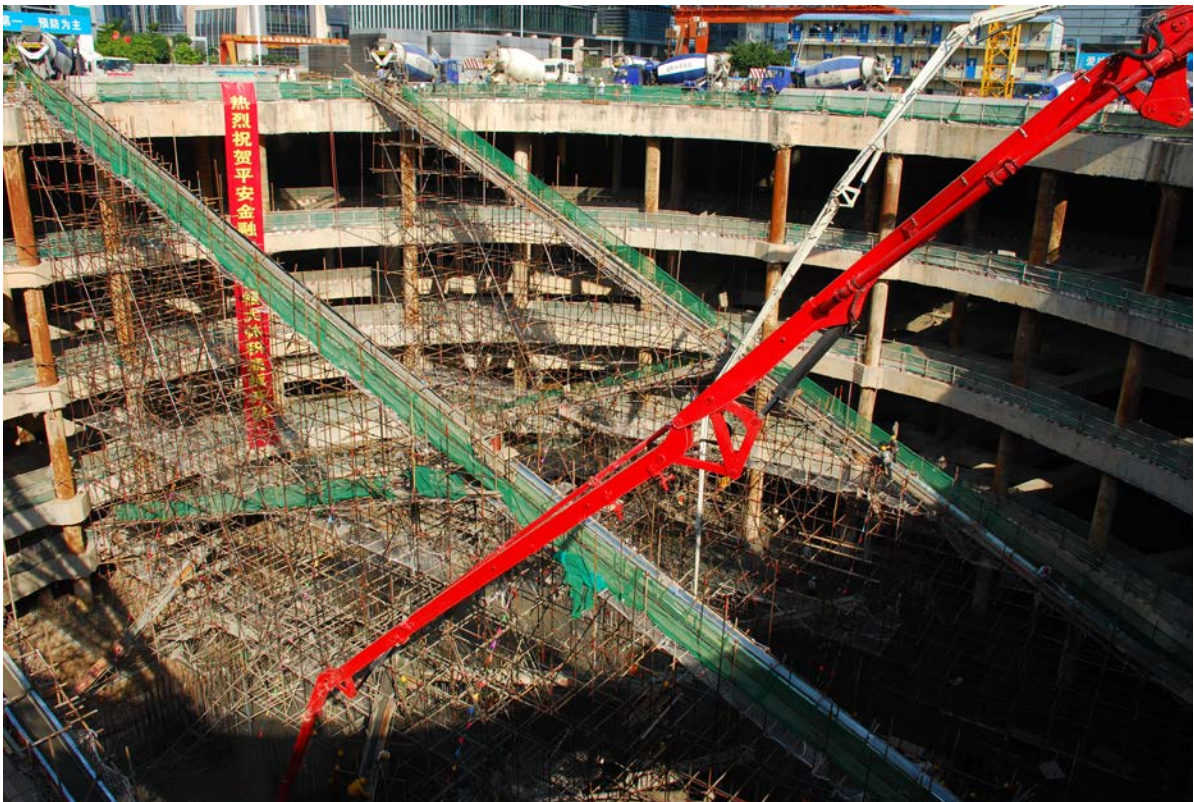
图 11.2-2 大溜槽和汽车泵就位
