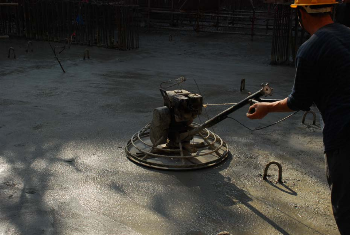
图 11.2-8 混凝土表面 抹光机抹压两遍找平 密实
