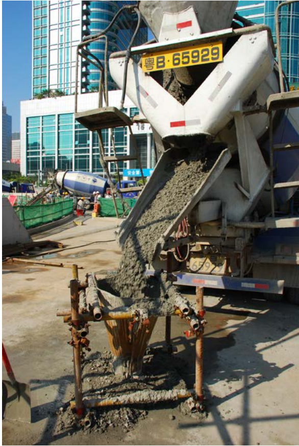
图 11.2-3 串筒下料 混凝土情况
