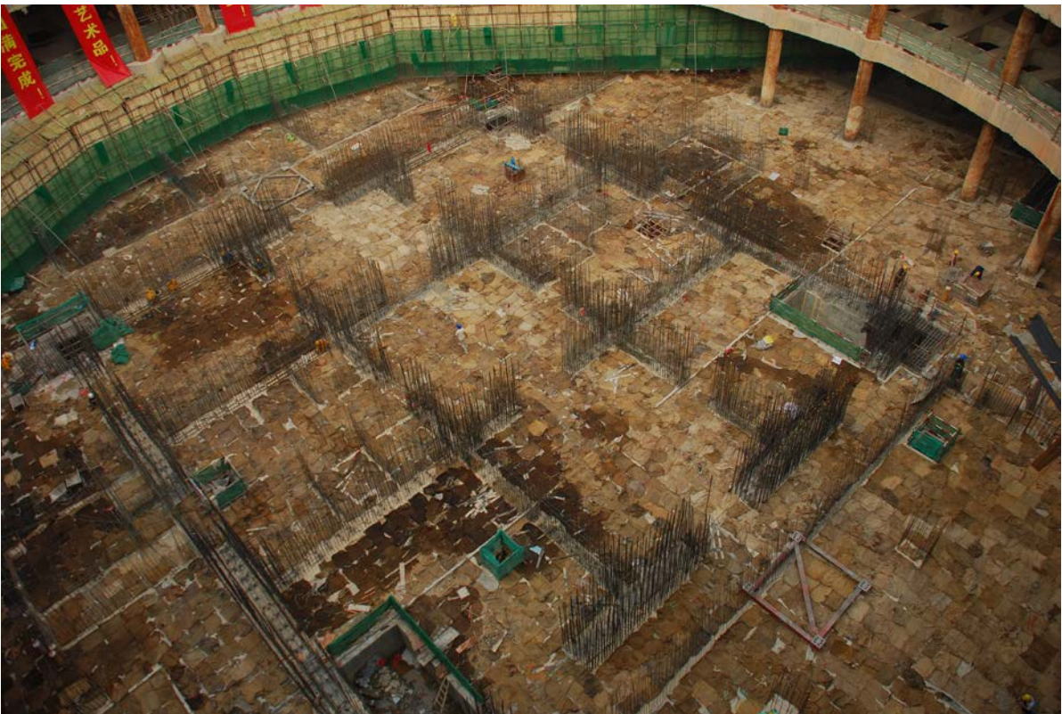
图 11.2-9 后期养护 塑料薄膜+麻袋片
