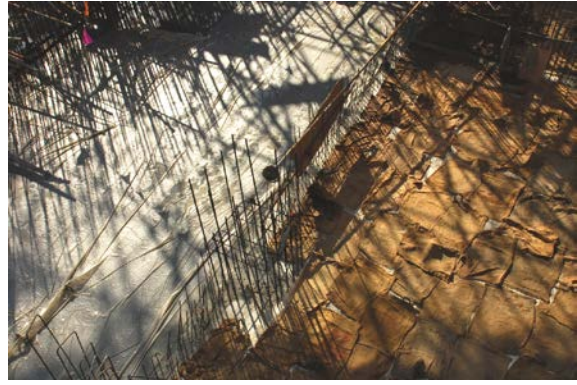
图 11.1-6 浇筑后保温养护
