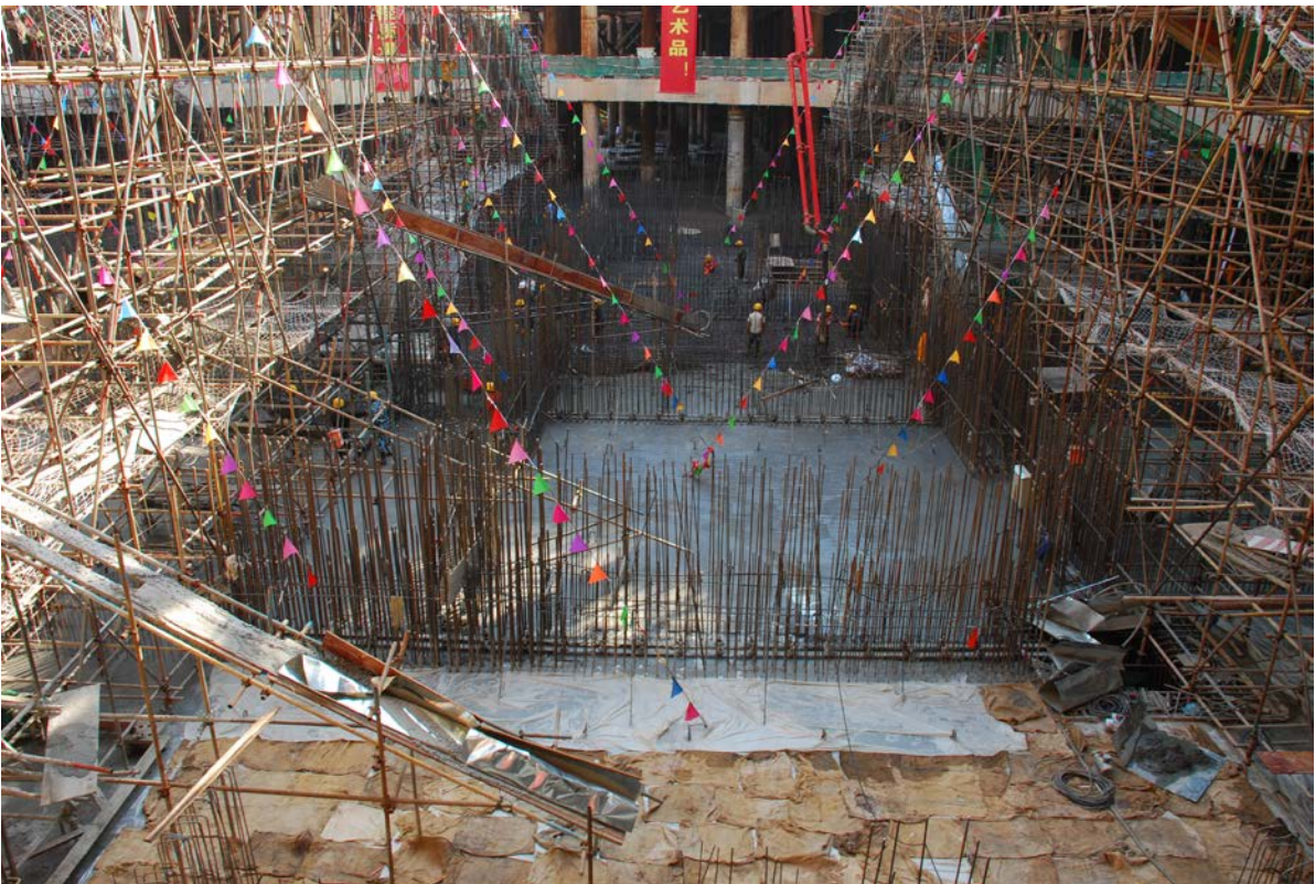
图 11.2-7 混凝土浇筑后 初期养护 覆盖保水塑料布 麻袋片
