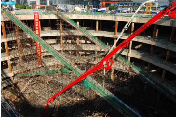
图 11.1-5 现场浇筑时照片
