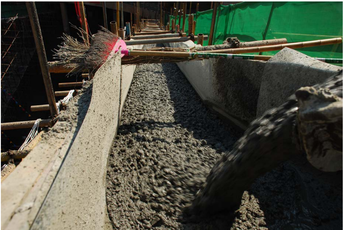
图 11.2-5 混凝土下流情况 (坍落度约 16cm 流动性好)
