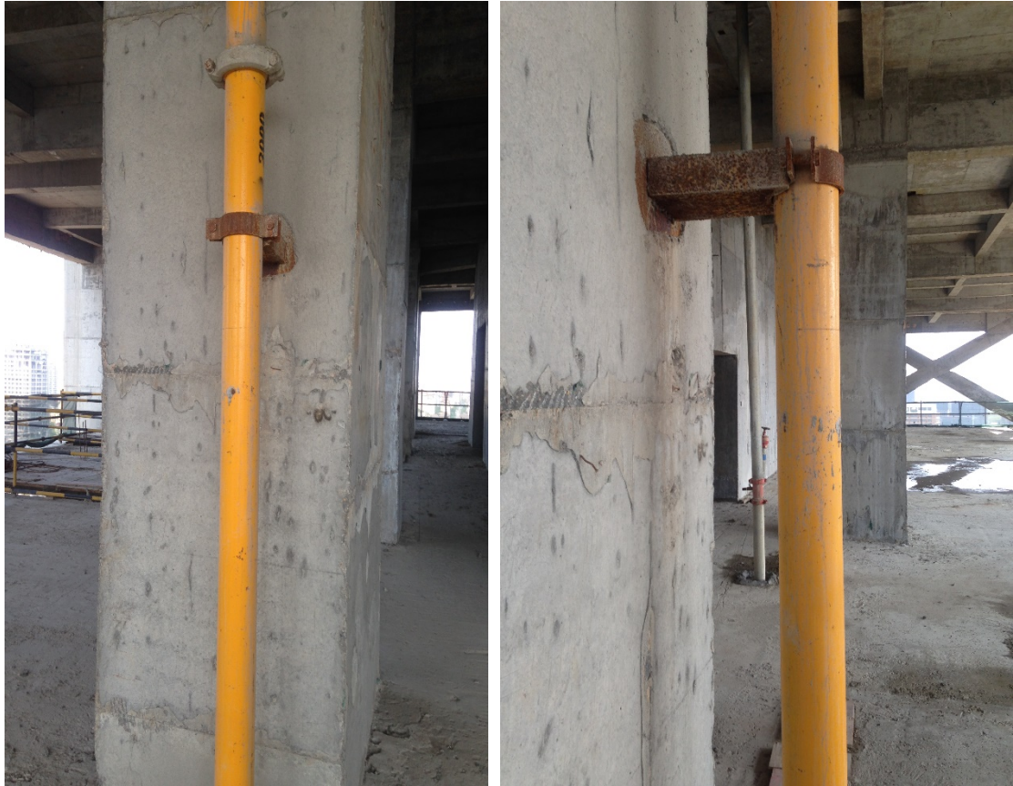
图 3 垂直管道固定方式
